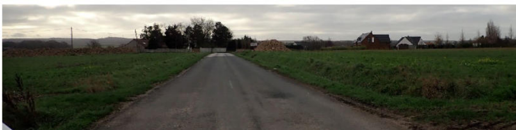
Rue d'Hames au nord du tissu urbain central : Ambiance agricole. La végétation n'intègre pas de bonne façon les bâtis. L'entrée de ville est peu qualitative.
