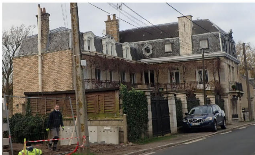
7- Bâti remarquable + clôture
