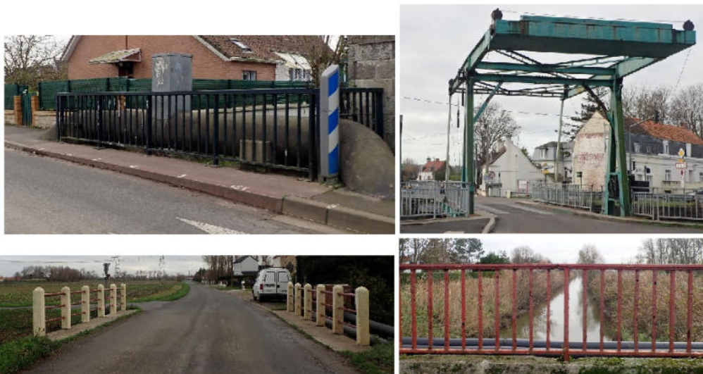
Exemples de ponts communaux
