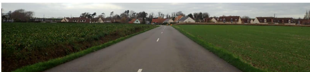
RD215 est : Ambiance agricole et urbaine. La végétation intègre peu ou pas les habitations. L'entrée de ville n'est pas qualitative.
