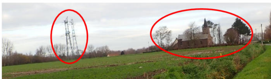
Exemple de covisibilité mêlant la chapelle aux lignes électriques
