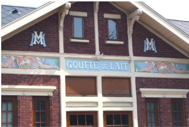
Bâtiment de la Goutte de Lait, Auchel
