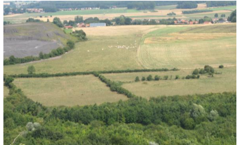
Haies bocagères sur les hauteurs d'Auchel et Marles
