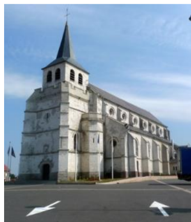
Eglise et place du centre d'Auchel
