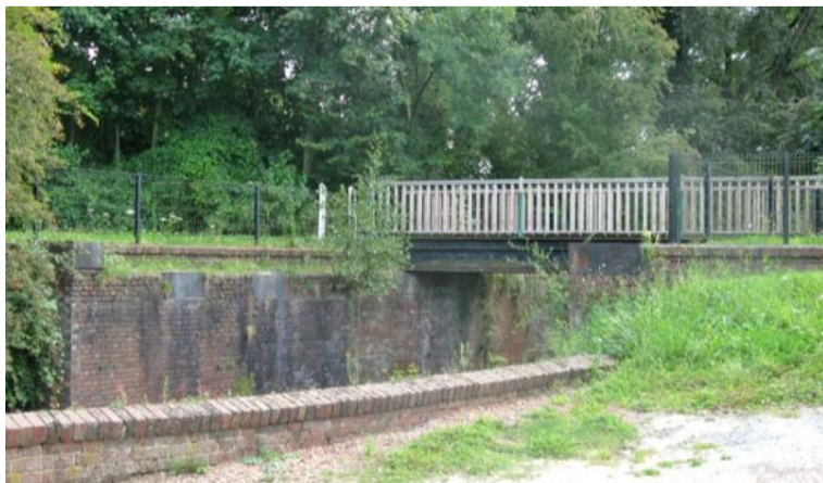
Pont ferroviaire au dessus de la Clarence, Marles
