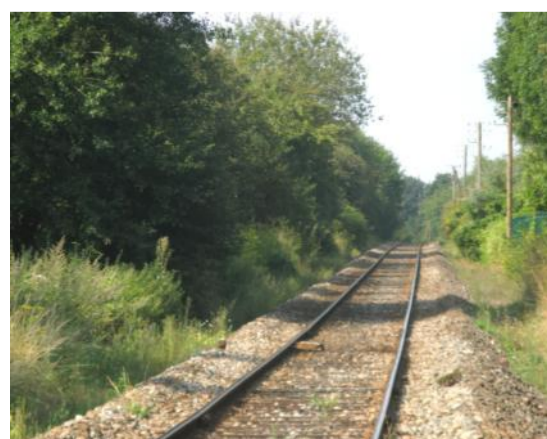
Voie ferrée St Pol-Lille
