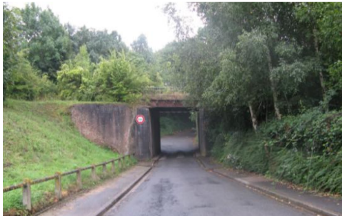
Passage sous pont, sous voie ferrée, Marles-les-Mines
