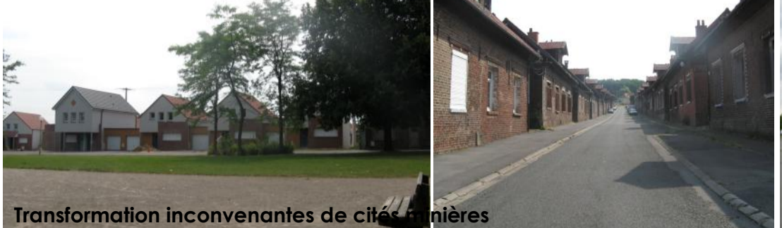
Nouvelles constructions, Cité du Rond Point / Voie « fantôme » et bâti en attente de démolition, Cité 6
