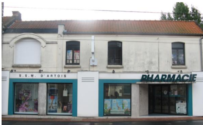
Ancien dispensaire SSM, reconverti en pharmacie, à Cauchy-à-la-Tour
