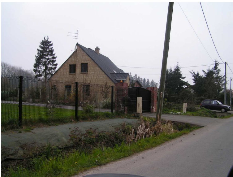
Construction de type pavillonnaire rue du Pacault
