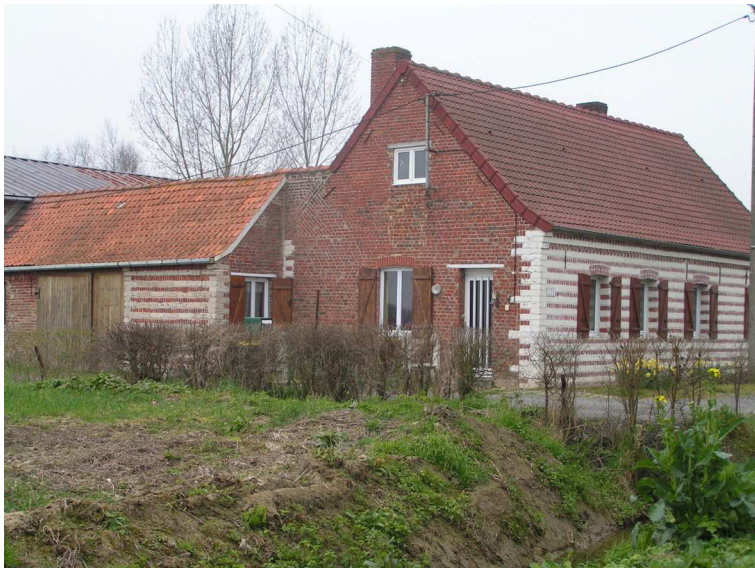
Construction de type rouge barre, ici, un seul rang de brique alterne avec un rang de pierre
