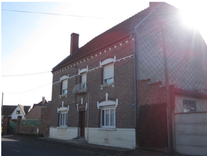
Habitat ancien dans le secteur Ua, implanté à l'alignement.
