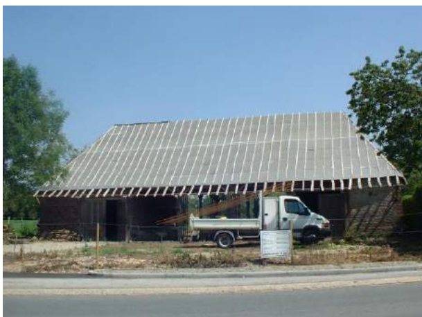
Réhabilitation sur l'axe de la RD 901 (R.N 1).
