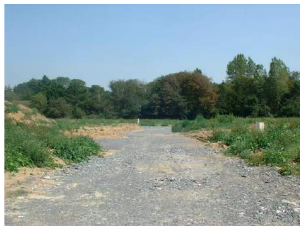
Lotissement en cours de réalisation, pour 15 logements.
