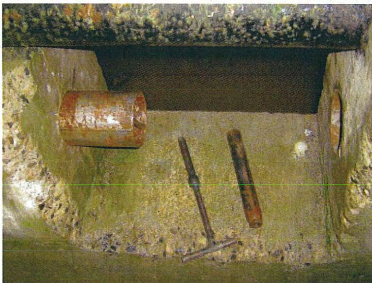
Système de barreau coulissant permettant l'entrée dans la cavité pour des suivis de chiroptères. Photo : H. Balmisse - CEPA
