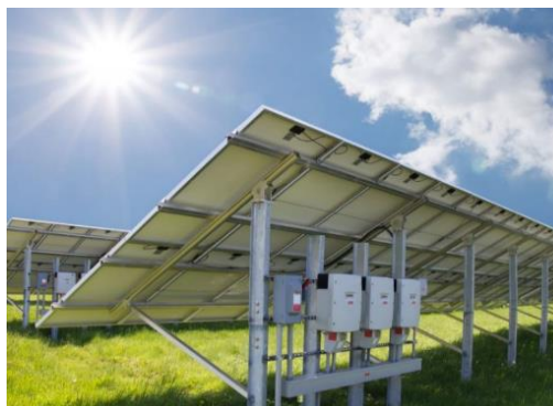
Comparaison de différents onduleurs : strings (onduleur solaire, s.d.) ou centralisé (SMA, s.d.)
