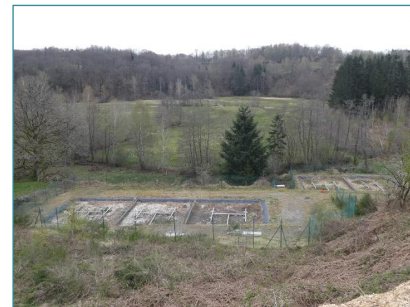
Vue depuis le site sur les bassins de lagunage (©CAMPUS)
