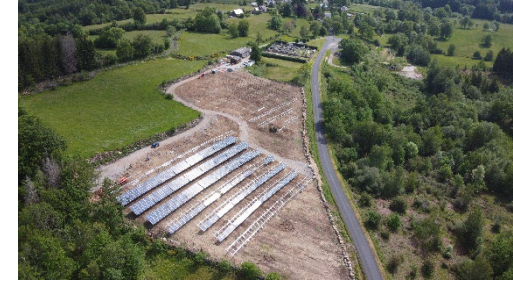
Travaux du parc photovoltaïque au lieu-dit « Clapeix » - @SIRE Conseil
