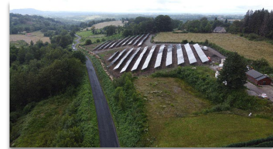
Parc photovoltaïque au lieu-dit « Clapeix » - @SIRE Conseil
