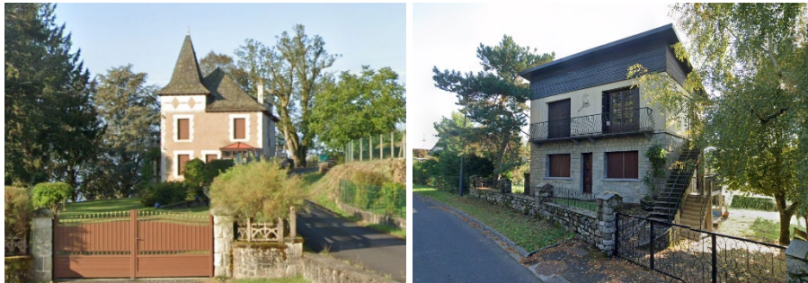
Exemples de constructions des années 30 et 60 @google street view
