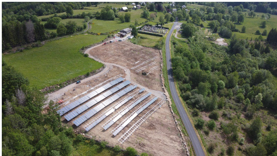
Travaux en cours du parc photovoltaïque au sol – vue de drone @SIRE Conseil
