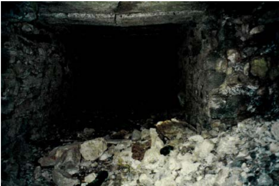
Photo 85 : Etat de la galerie Denières avant travaux
