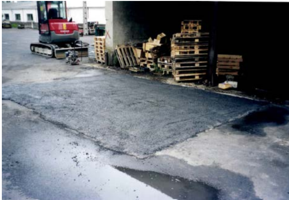
Photo 59 : Site de l'aération du petit puits de Cellamines après travaux
