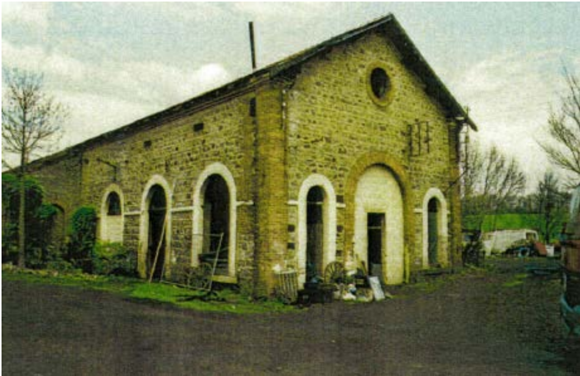
Photo 136 : Site du puits de Grosménil avant travaux
