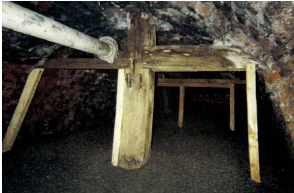
Photo 109 : Bétonnage de la galerie du Rouge
