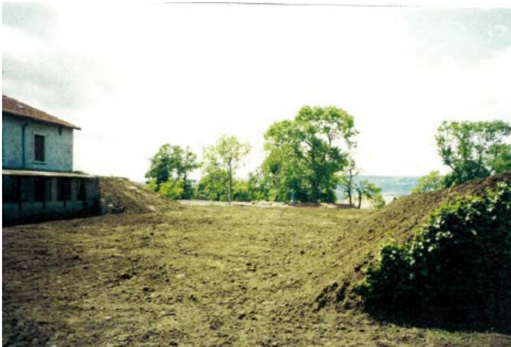
Photo 127 : Site du puits de Coincy après travaux
