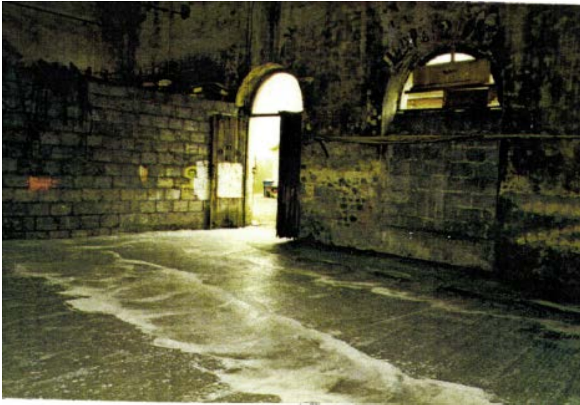
Photo 140 : Puits de Grosménil après travaux
