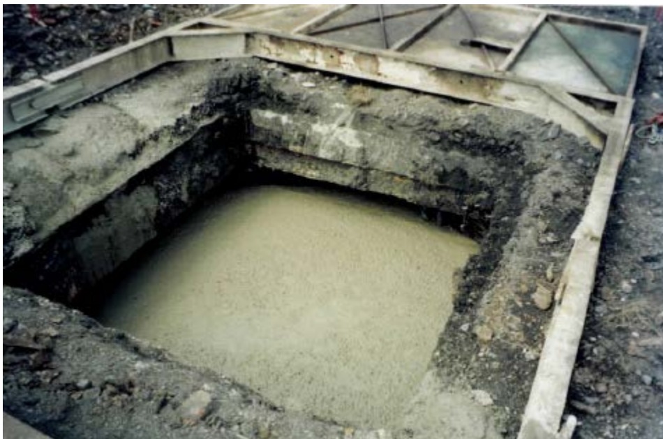
Photo 51 : Coulage du bouchon béton au puits de Cellamines
