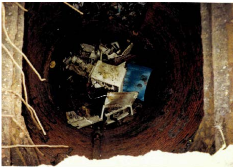
Photo 102 : Puits de l'Ouest avant travaux
