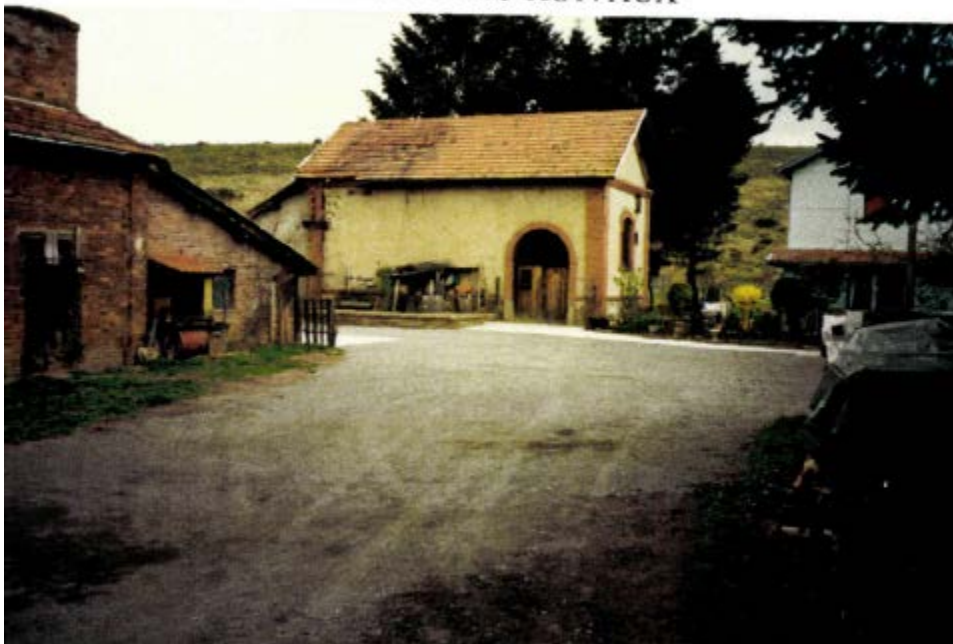
Photo 99 : Site du puits Morny après travaux
