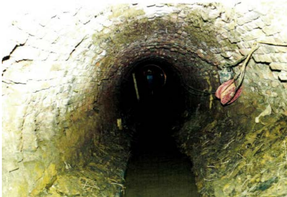
Photo 79 : Tunnel de Fondary avant travaux
