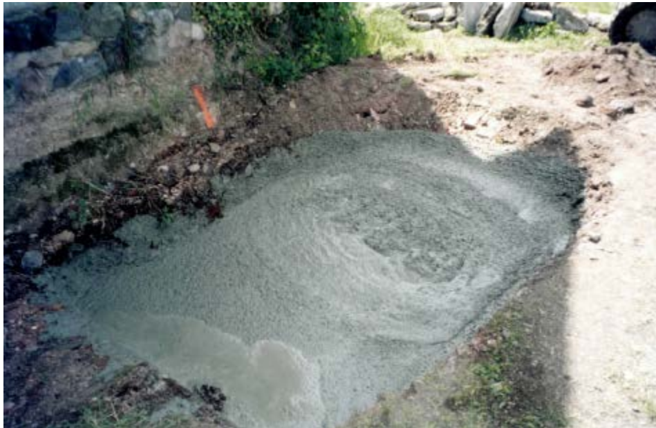
Photo 71 : Remblayage en béton de la galerie d'aérage 2
