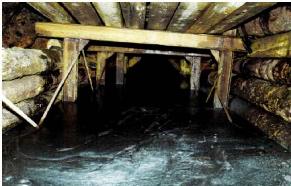
Photo 82 : Embouage du tunnel de Fondary (vue intérieure)
