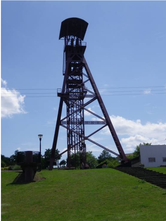
Photo 39 : Puits des Graves (P9) - Combelle
