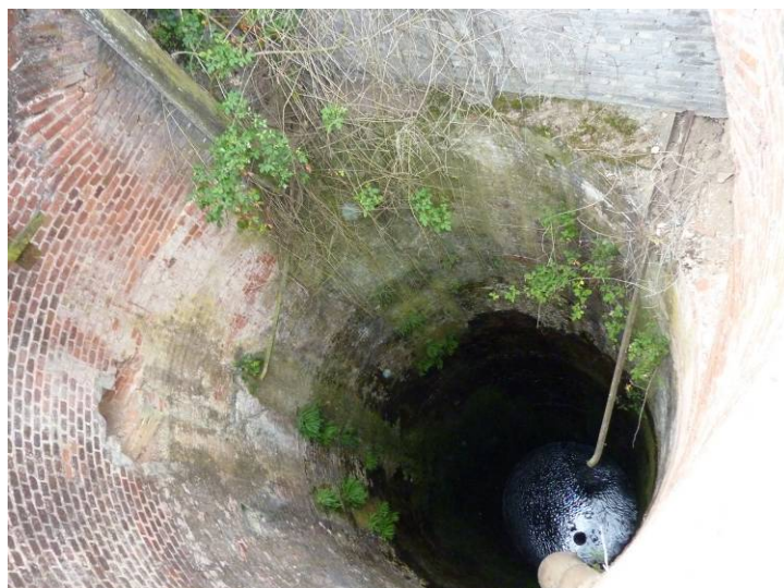
Photo 15 : Puits de Monteil
