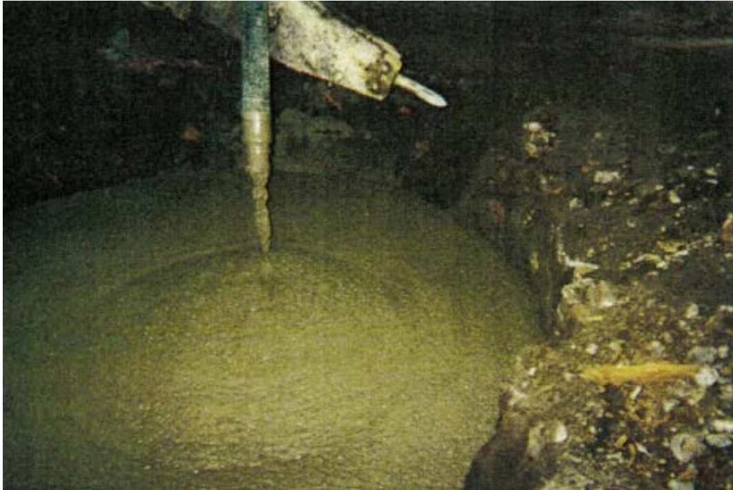
Photo 138 : Coulage du bouchon béton du puits de Grosménil
