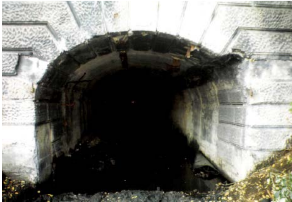
Photo 61 : Tunnel du puits des Graves avant travaux
