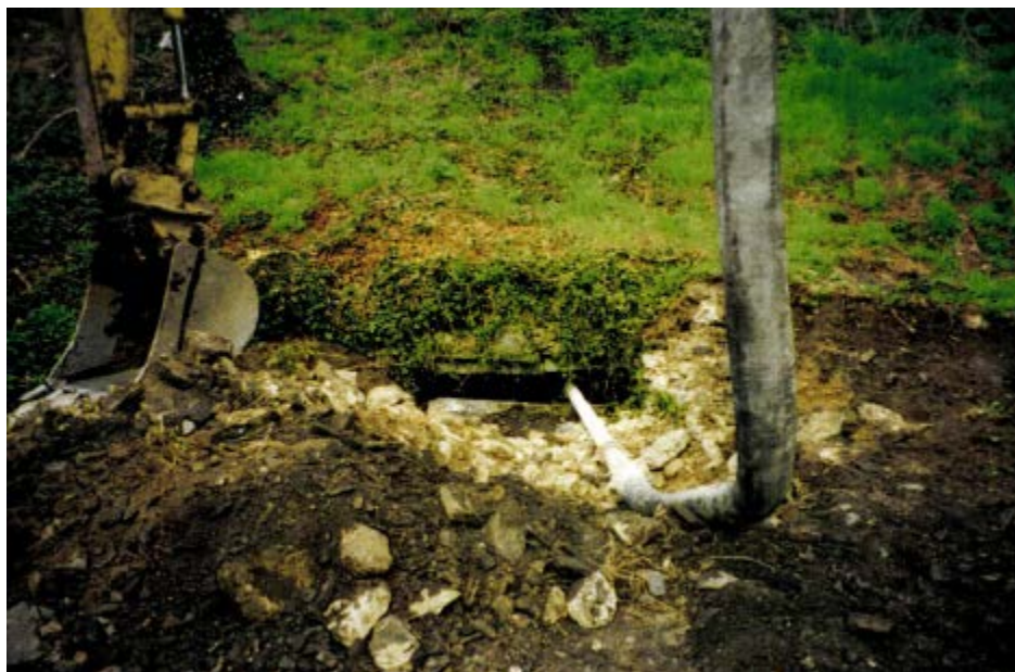
Photo 86 : Coulage du béton dans la galerie Denières
