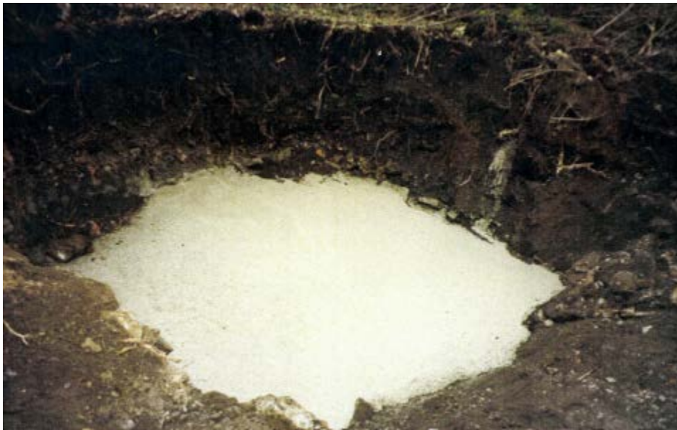
Photo 93 : Coulage de la dalle en béton armé du puits des Echelles
