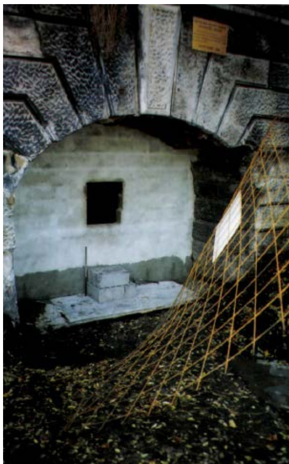
Photo 63 : Mise en place d'un mur étanche et d'un tuyau PVC à l'entrée du tunnel du puits des Graves
