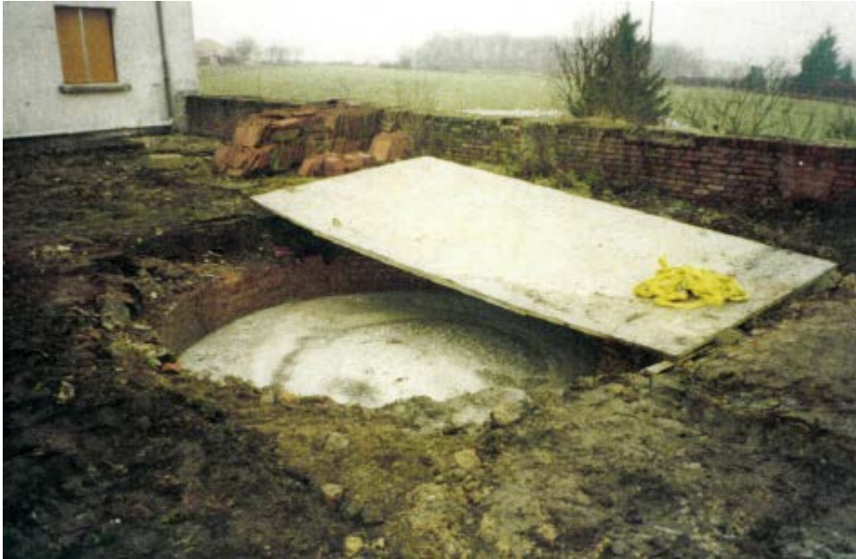
Photo 105 : Bouchon béton du puits de l'Ouest
