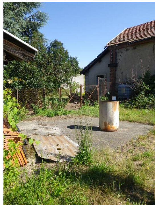
Photo 43 : Dalle à l'plomb du puits Morny (P103) - Barthes
