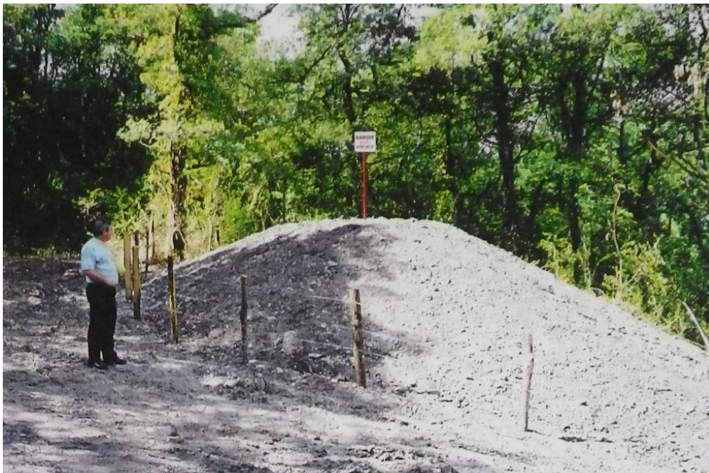
Photo 142 : Puits Sabatier après travaux
