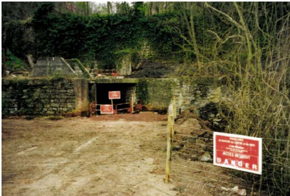
Photo 107 : Galerie du Rouge avant travaux
