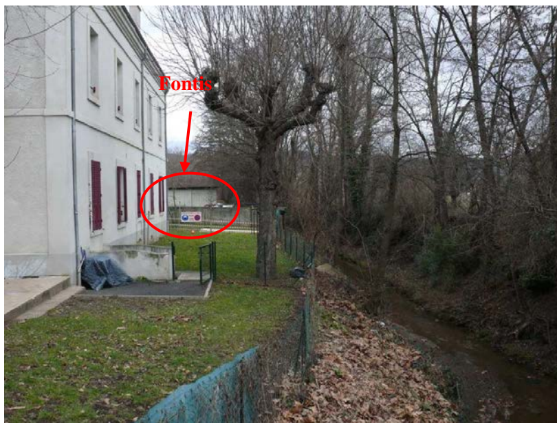
Photo 4 : Localisation du fontis d'Arrest (Source : GEODERIS, 2008)
