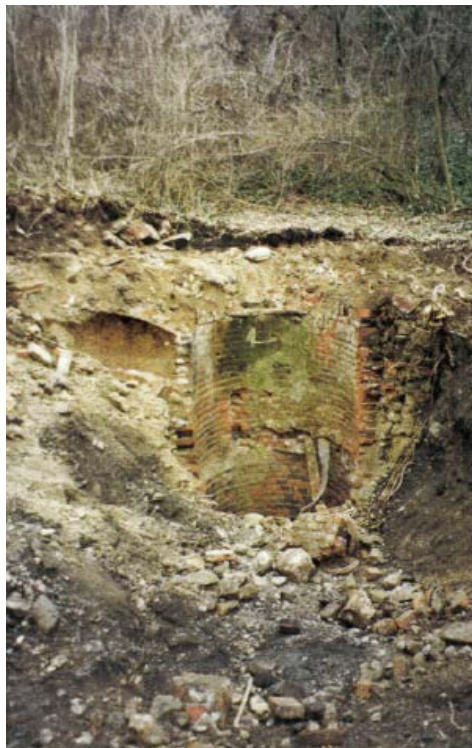
Photo 91 : Puits des Echelles avant travaux
