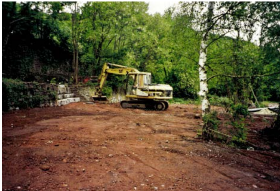
Photo 112 : Remise en état après travaux du site de la galerie du Rouge
