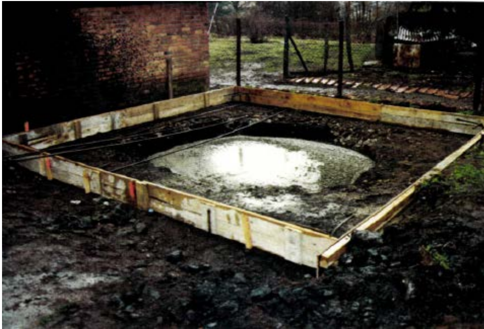
Photo 98 : Coulage du bouchon béton du puits Morny
