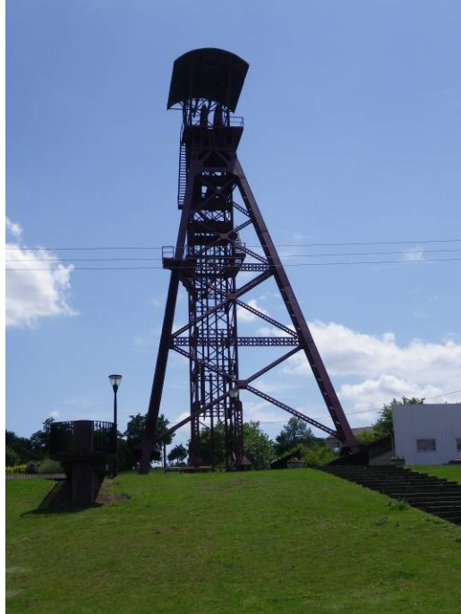
Photo 20 : Chevalement du Puits des Graves
