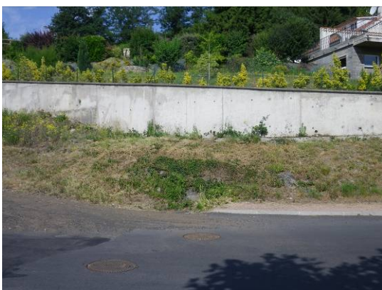
Photo 41 : Galerie G7 - Armois
