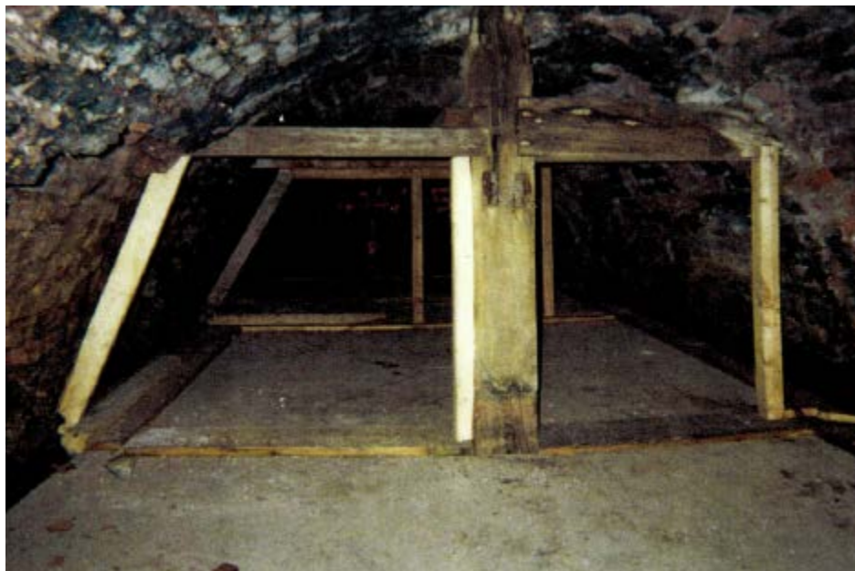
Photo 108 : Plancher de bois sur gravier
