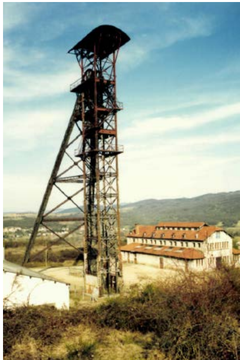
Photo 47 : Puits des Graves avant travaux
