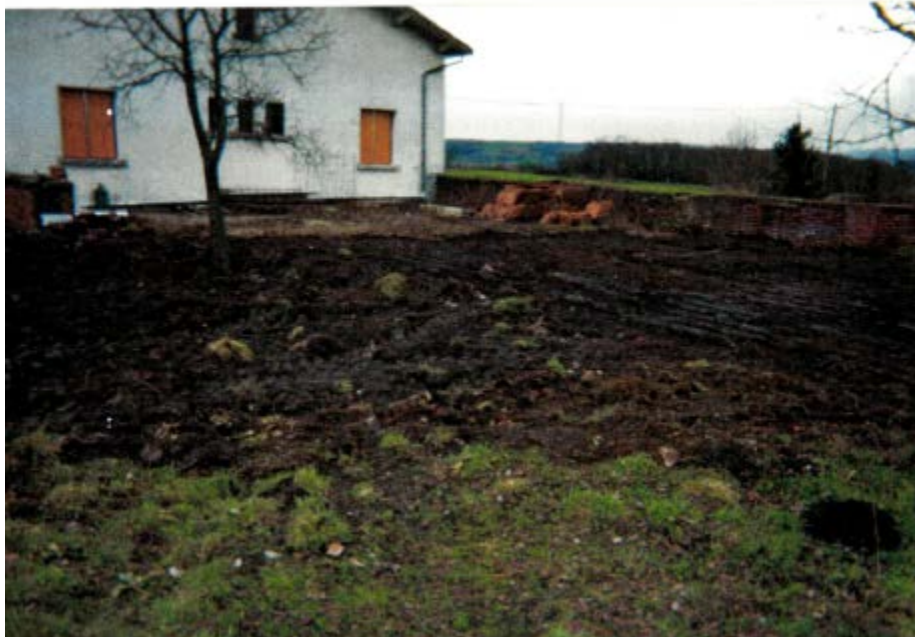
Photo 106 : Site du puits de l'Ouest après travaux
