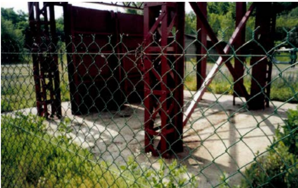
Photo 49 : Dalle de béton armé du puits des Graves
