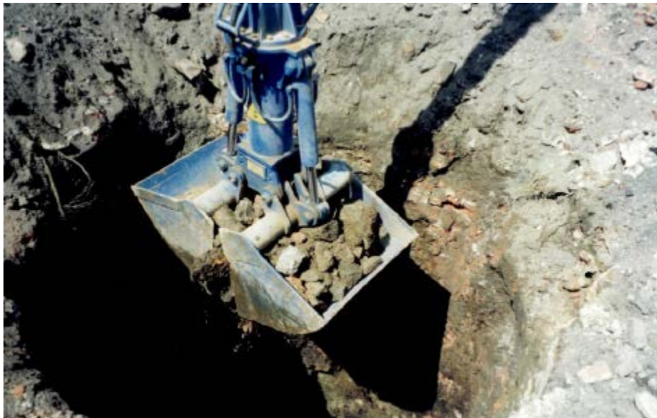
Photo 52 : Curage du puits de Basse-Combelle
