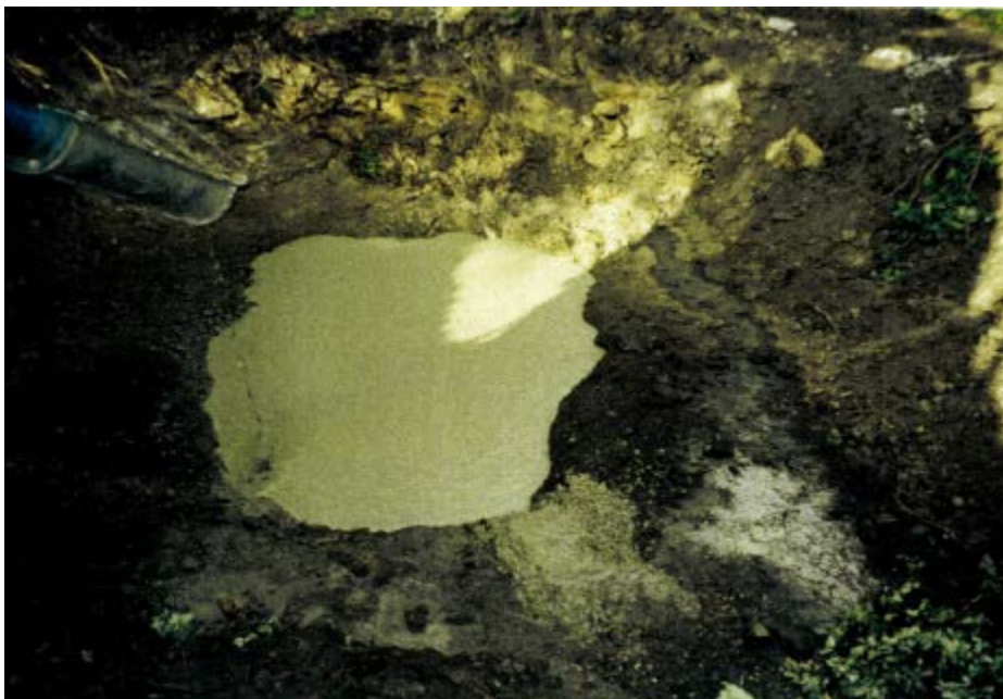
Photo 132 : Coulage du bouchon béton au puits de Tinderelle
