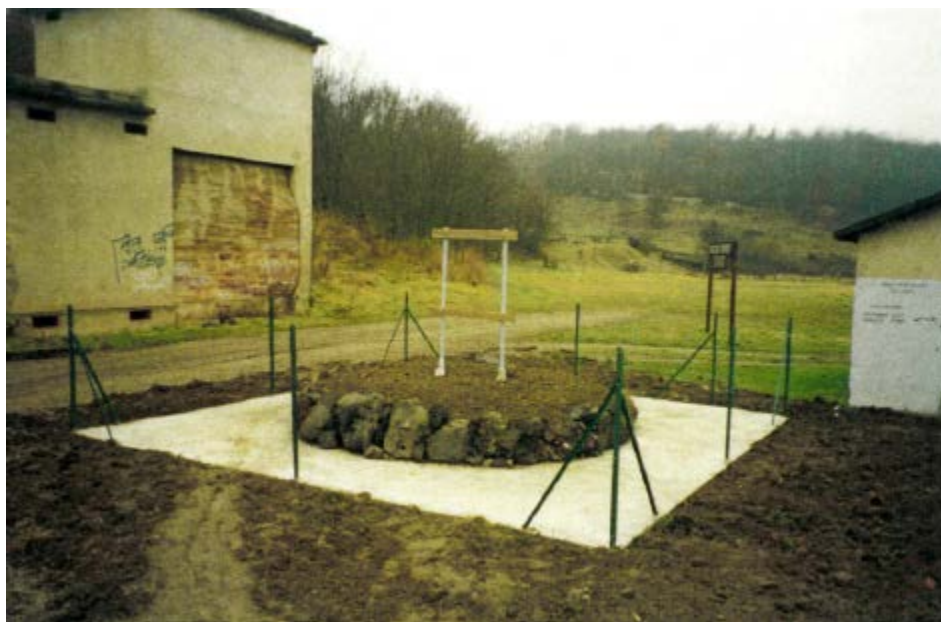
Photo 96 : Puits du Parc après travaux
