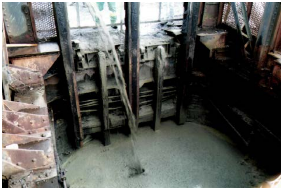
Photo 50 : Coulage du bouchon béton du puits Bayard
