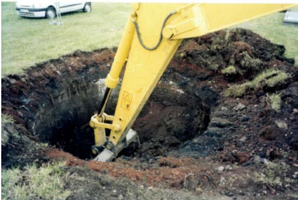
Photo 65 : Curage du puits Saint-Alexandre
