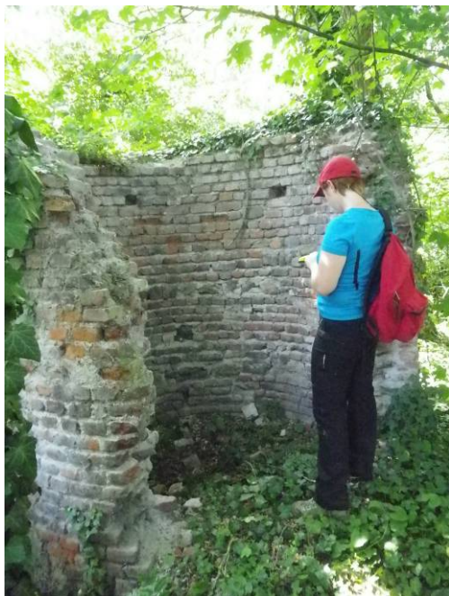
Photo 44 : Puits P153 - Grosménil
