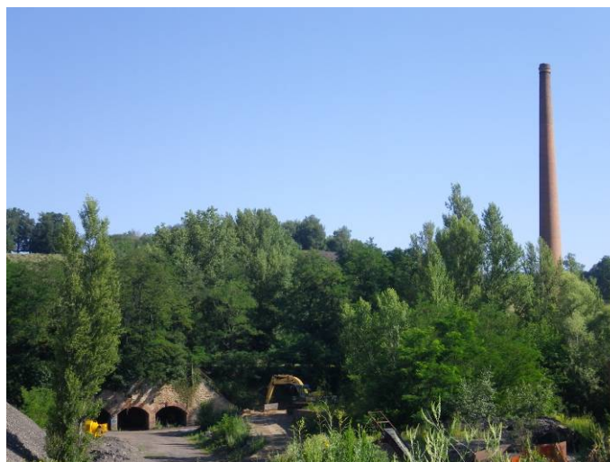
Photo 16 : Vue d'ensemble de l'ancienne installation
