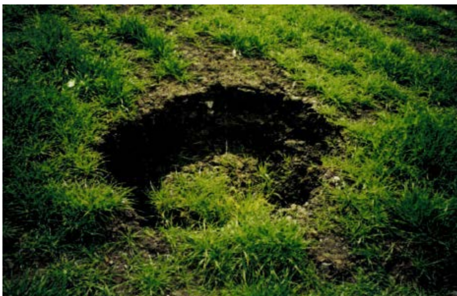
Photo 130 : Puits de la pompe avant travaux
