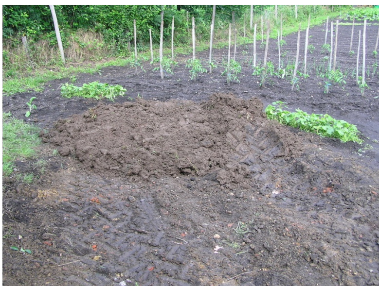
Photo 11 : Remblayage du fontis D10
