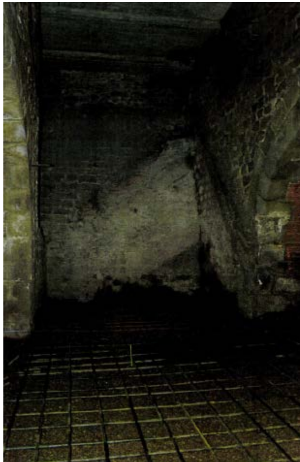
Photo 76 : Ferrailage de la dalle de la salle du puits des Vignes
