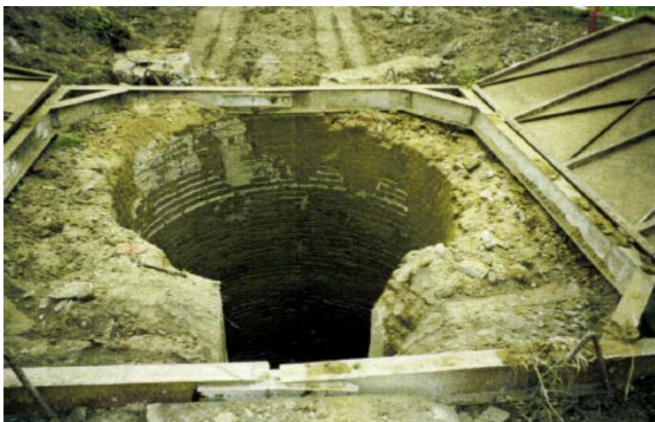
Photo 120 : Puits de Chamblève avant travaux
