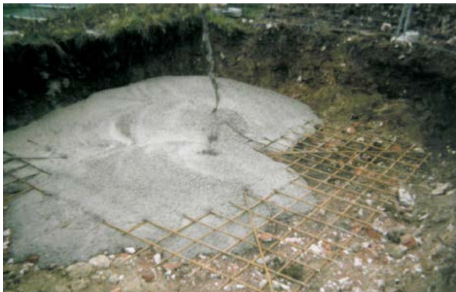
Photo 74 : Coulage de la dalle au puits du Grand Pré
