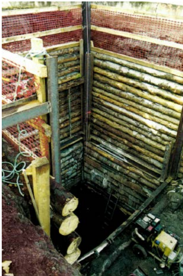
Photo 80 : Blindage du puits de service du tunnel de Fondary
