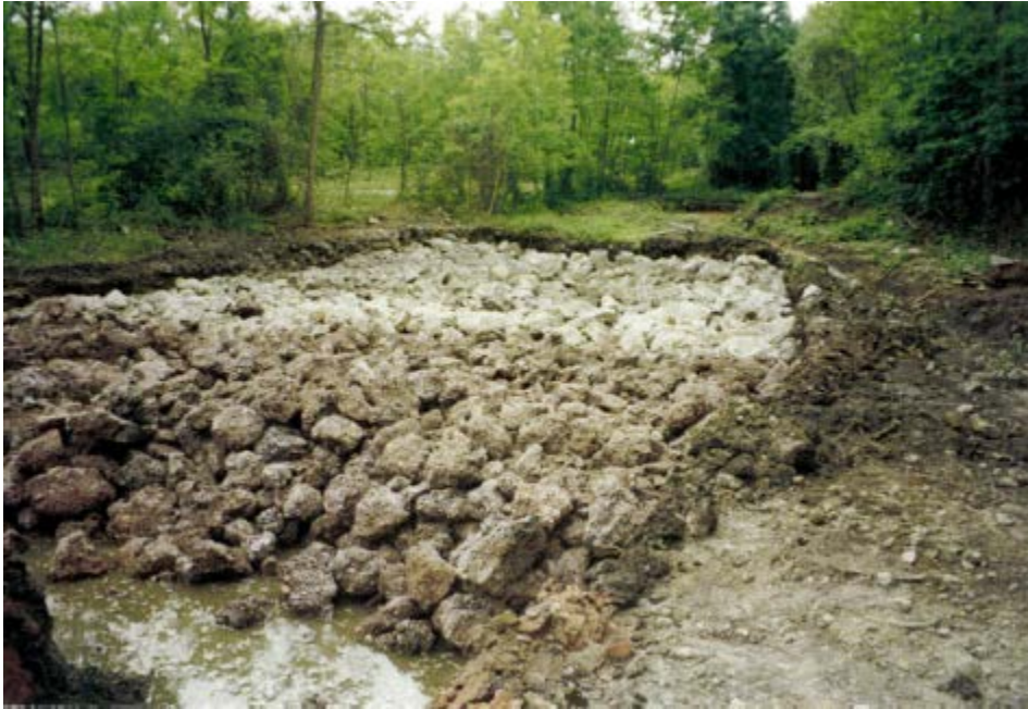
Photo 111 : Plateau absorbant rempli de mâchefer
