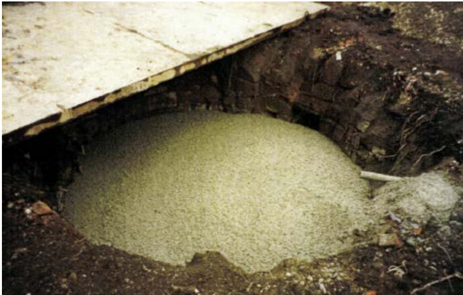
Photo 89 : coulage du bouchon béton du puits Denières
