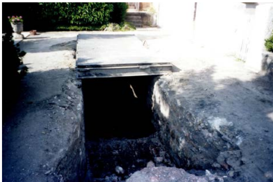
Photo 55 : Recherche du puits de la Verrerie
