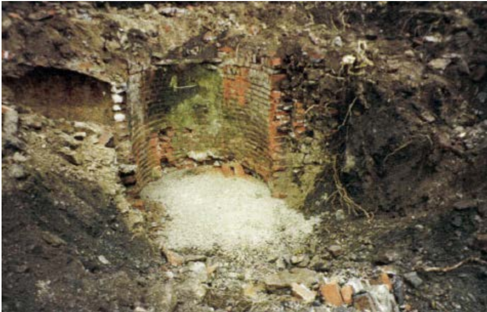
Photo 92 : Coulage du bouchon béton du puits des Echelles
