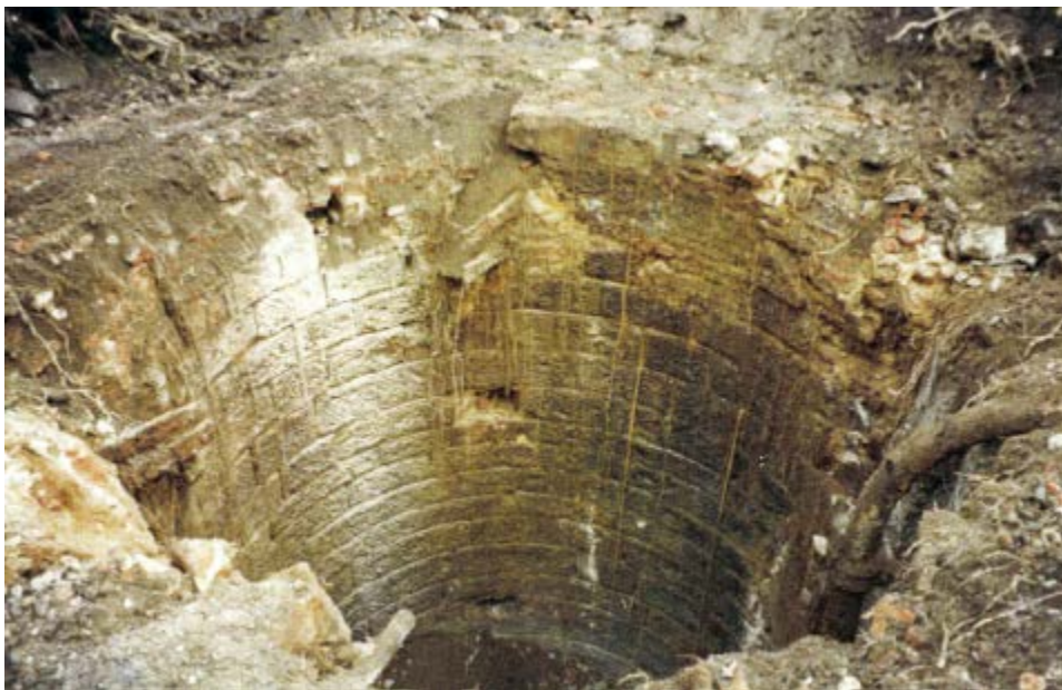
Photo 88 : Puits Denières avant travaux
