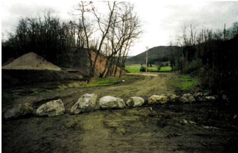
Photo 115 : Site des anciens tunnels de La Taupe après travaux
