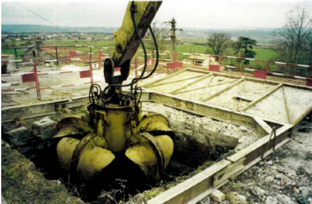
Photo 124 : Décaissement du puits de Coincy
