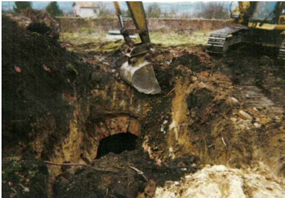
Photo 103 : Démolition de la galerie d'aérag
