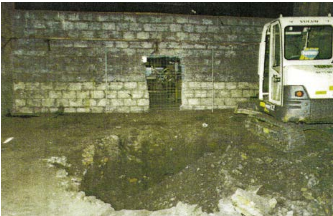
Photo 137 : Puits de Grosménil avant travaux
