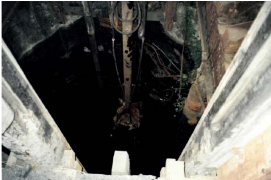
Photo 48 : Curage du puits des Graves
