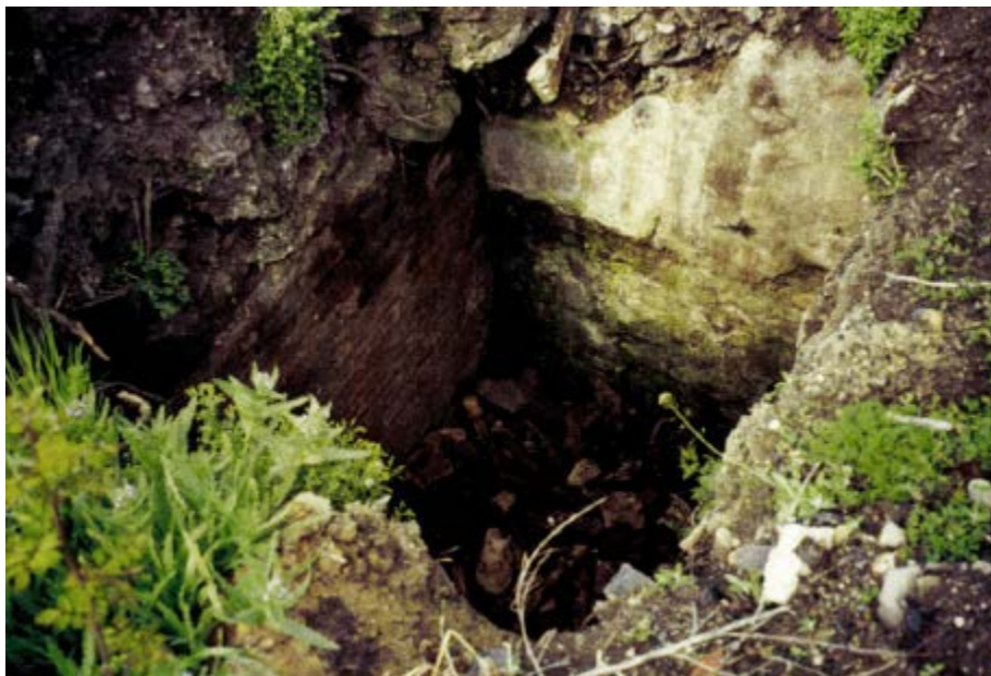
Photo 128 : Puits de la Cloche avant travaux
