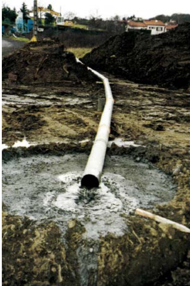
Photo 81 : Embouage du tunnel de Fondary (vue extérieure)
