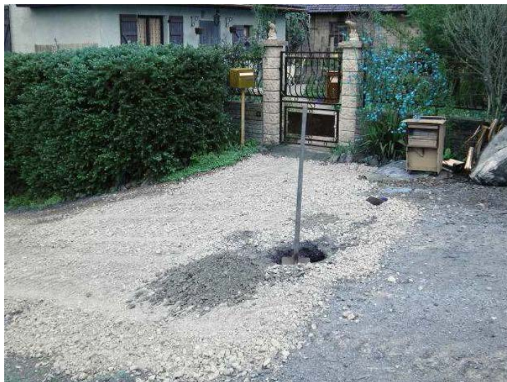
Photo 3 : Entonnoir redébouché pour la visite de la DRIRE (Source : GEODERIS, 2008)
