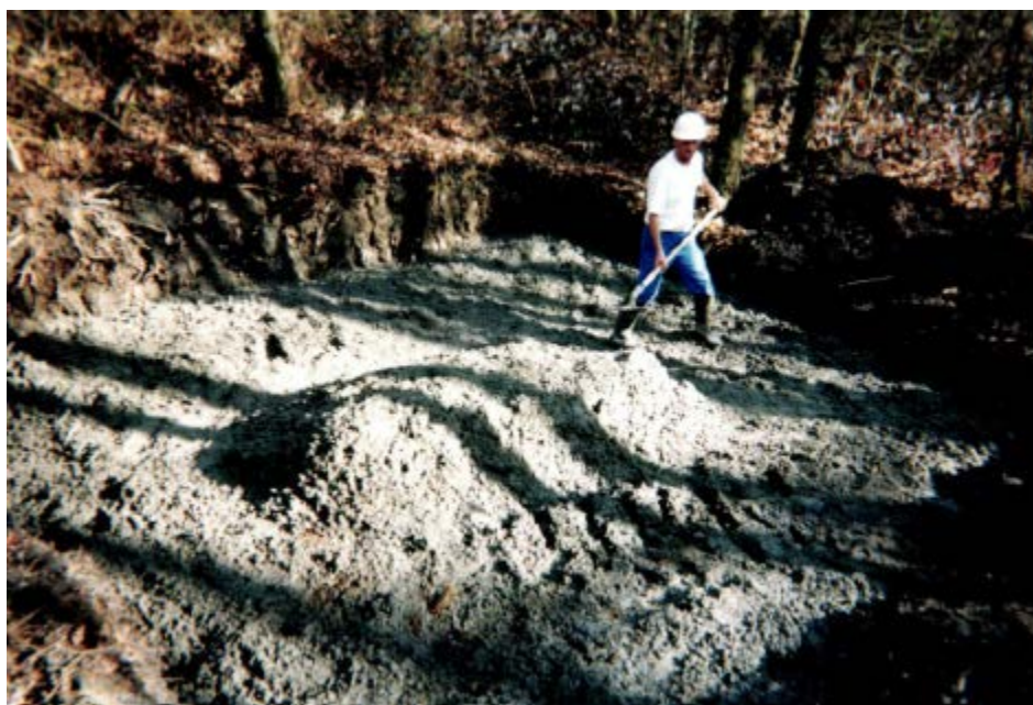
Photo 60 : coulage de la dalle en béton armé au puits Sauvât 1
