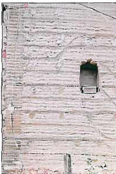
détail de matériau : le pisé
