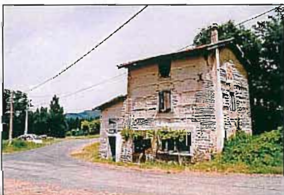
construction traditionnelle en pisé, Le Canelier
