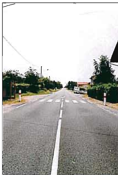
RD906 en direction de Thiers, traversée de la Croix Saint Bonnet
