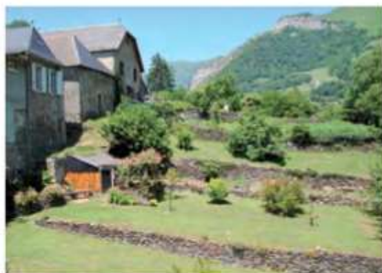
Murs de soutènements entre parcelles
