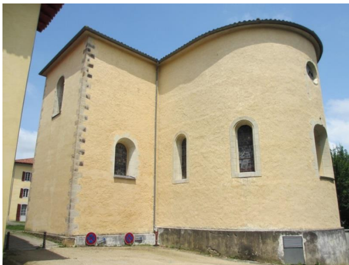
Fig. 132. La chapelle du séminaire
