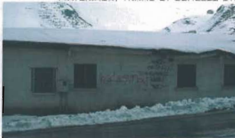
FAÇADE ARRIÈRE DÉLAISSÉE
