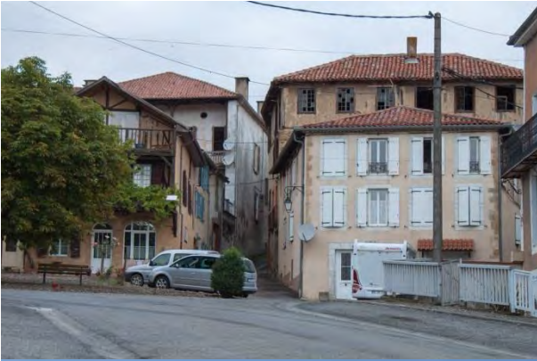
Figure 11 - Place de la Pourcaou et rue Pierre de Sainte Anne : continuité des façades le long des voies publiques
