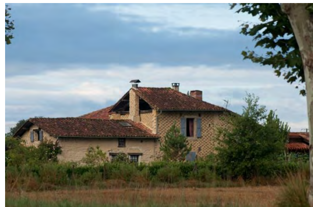
Figure 17 - Exemple de bâti agricole traditionnel (quartier « Paillet »)
