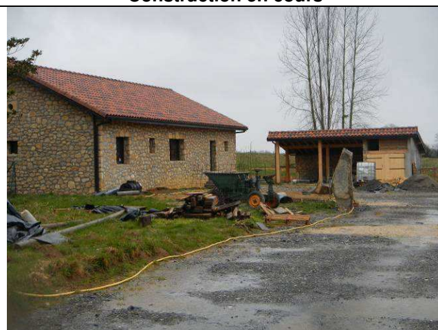
Construction en cours
