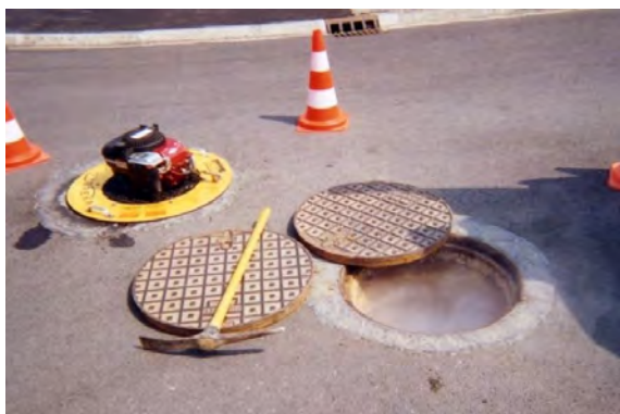
Figure 12-Exemple de tests à la fumée
