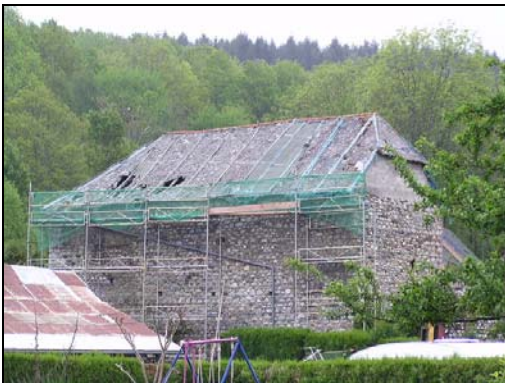
Réhabilitation du bâti ancien
