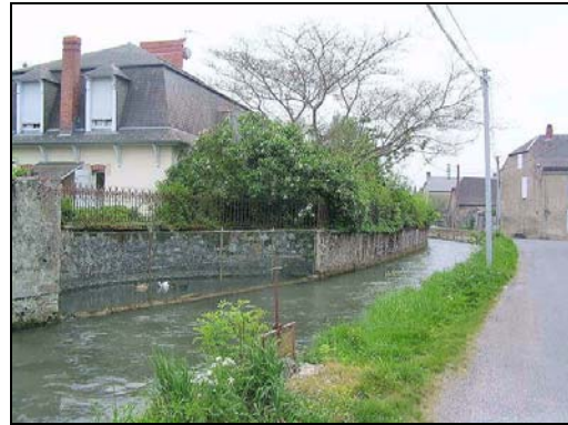
Canal de l'Alaric en bordure de la RD 87
