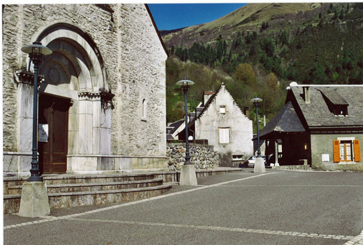
Porche et parvis de l'église, au fond une petite halle au pignon d'une maison
