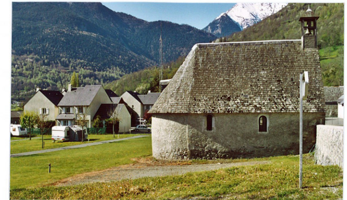
Chapelle à l'entrée nord du bourg
