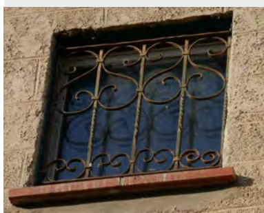
Ferronneries : grille de défense en fer forgé
