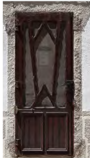
Laroque-des-Albères Porte vitrée équipée d'une moustiquaires ouvragée
