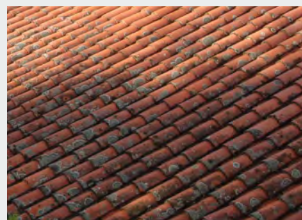
Toiture en tuile canal
