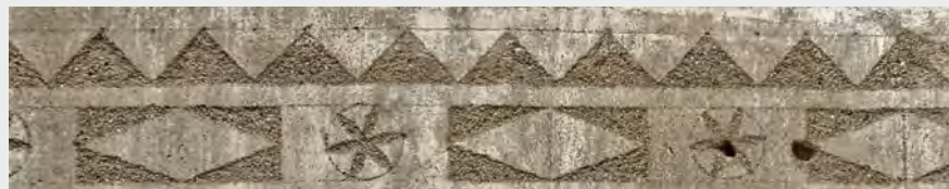
Bandeau en enduit sgraffite
