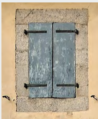
Encadrement en granit et contrevent simple en planches à deux vantaux
