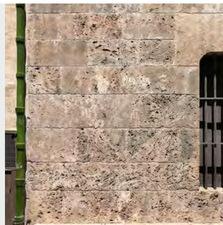
Mur en pierres taillées (Perpignan)
