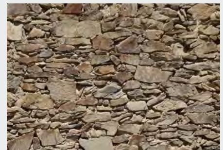
Jujols - murs de moellons en schiste
