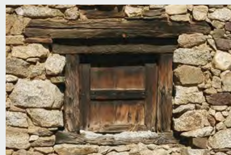
Fenestrou - linteau et encadrement en bois
