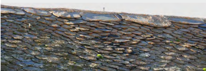
Faitage d'une toiture en llose
