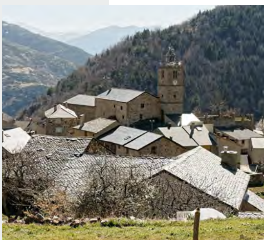
Les lloses sont taillées en écailles. La partie découverte et l'épaisseur des tuiles en llose sont de taille irrégulière.
