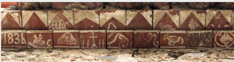
Sous-face de corniche peinte. C'est une spécificité catalane et majorquine. On ignore l'origine de ces décors peints au lait de chaux. Ici, il y a un mélange de triangles et de dessins « symboliques ».
