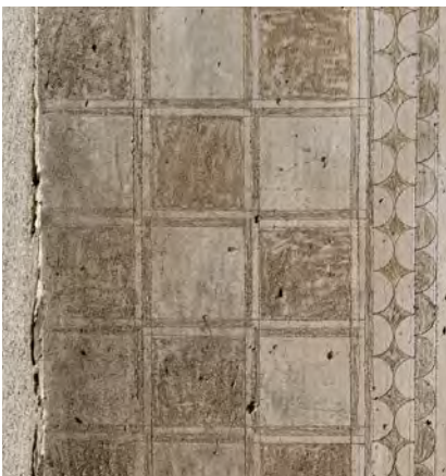
Chaîne d'angle en enduit sgraffite
