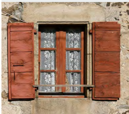
Encadrement à feuillure* en pierre de taille. Contrevent à planches horizontales jointives en face interne. Fenêtre à petit bois
