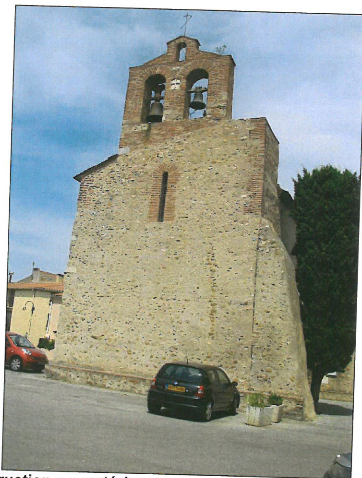
Une construction en matériaux typiques de la plaine du Roussillon, avec un 'clocher-mur' nommé 'clocher-pignon' ou 'clocher-arcade' dans le cas présent.
