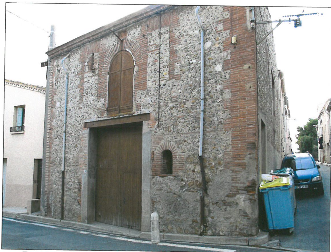
Exemple de bâtisse traditionnelle sur l'avenue de Canohès. Les caractéristiques de la maison 'catalane' en galets et cayroux sont présentes.
