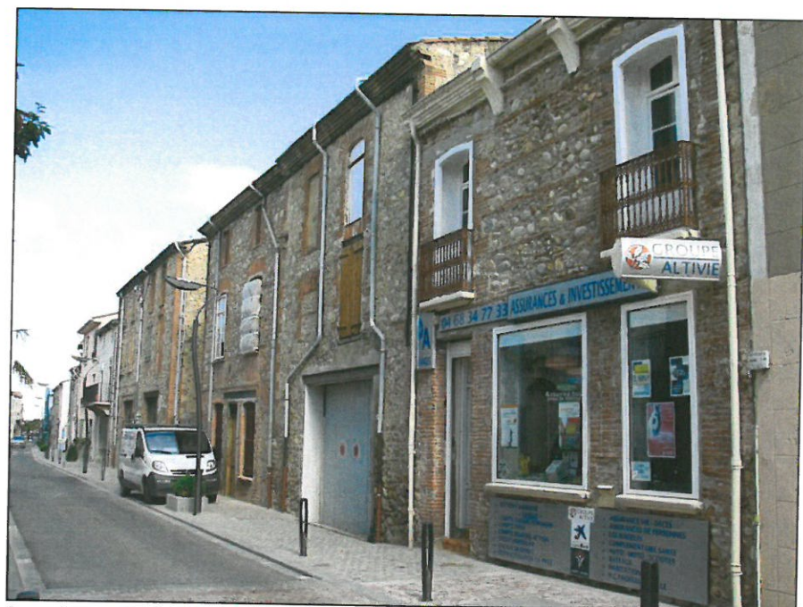
Un prédominance des façades en galets. A noter, la reconversion du bâti ancien en commerces
