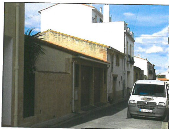
Côté Nord, de nombreux travaux
