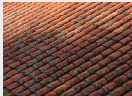
Toiture en tuile canal
