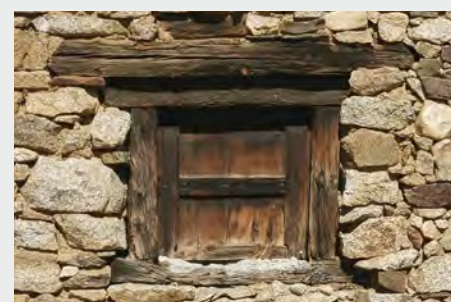
Fenestrou - linteau et encadrement en bois
