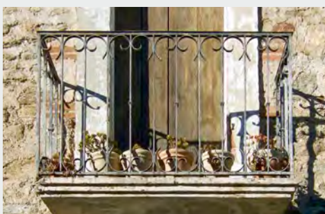
Garde-corps en fer forgé
