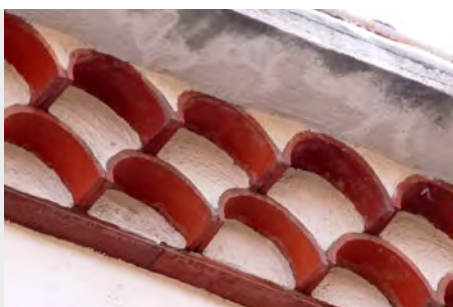
Génoise à plusieurs rangées de tuiles
