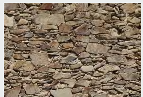
Jujols - murs de moellons en schiste
