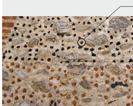
Joints avec inclusion de mâchefer* ou de terre cuite (cayrou)
