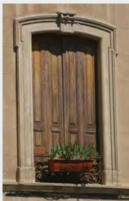
Contrevents à brisures verticales (se pliant en tableaux dans le sens de la hauteur)
