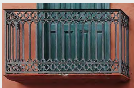
Garde-corps en fonte
