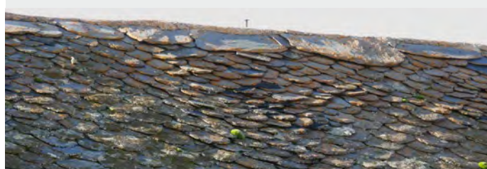
Faitage d'une toiture en llose
