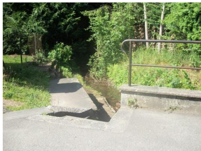
La ripisylve en zone urbaine
