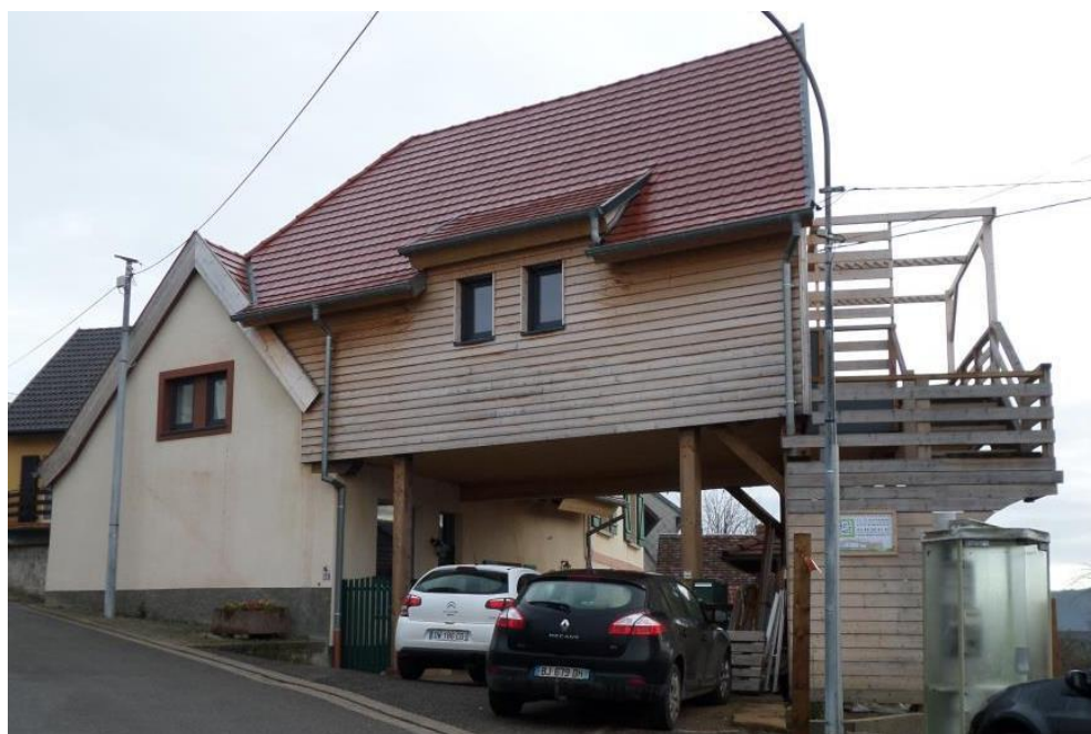
Exemple d'une réhabilitation en demi-teinte
