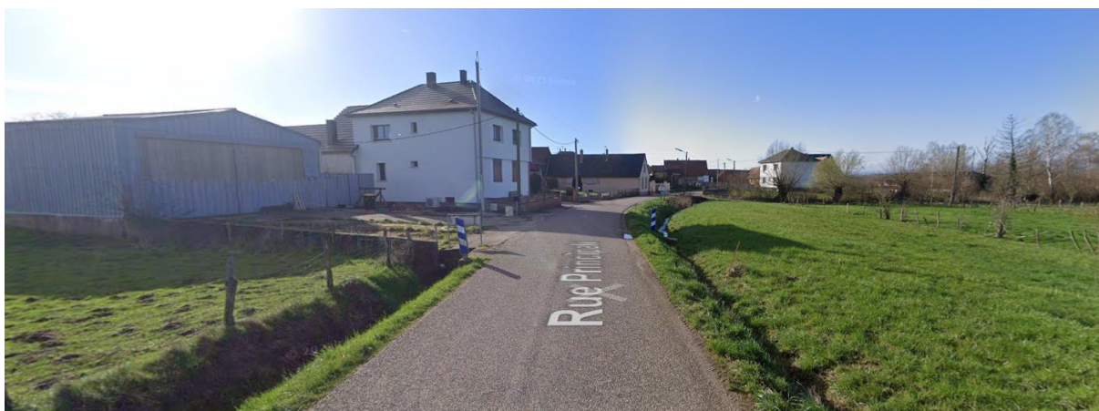
Vue de l'entrée Nord – Source : extrait StreetView – 2023
