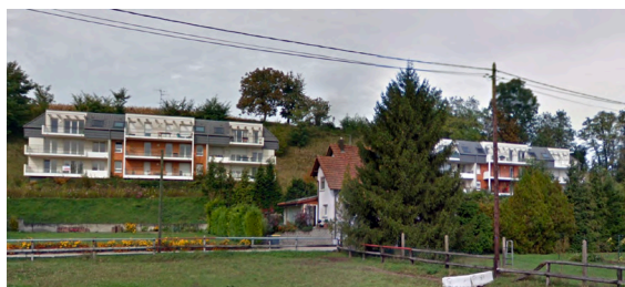
Domaine des Coteaux, rue Principale : habitats collectifs en pied de colline, sans atteinte à celle-ci
