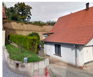
Habitat rue du Village implanté par la création d'une tranchée dans le relief
