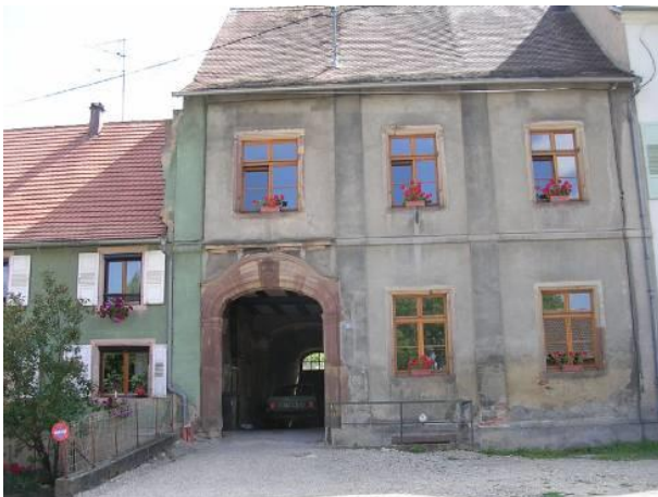
Alignement du bâti conventuel rompu par la disparition d'une partie des bâtiments, rue du Schlossgarten
