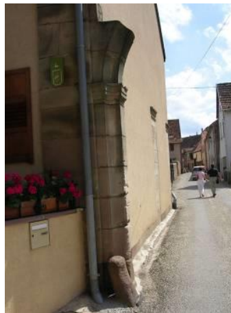
Vestige d'un encadrement de porte, rue du Couvent
