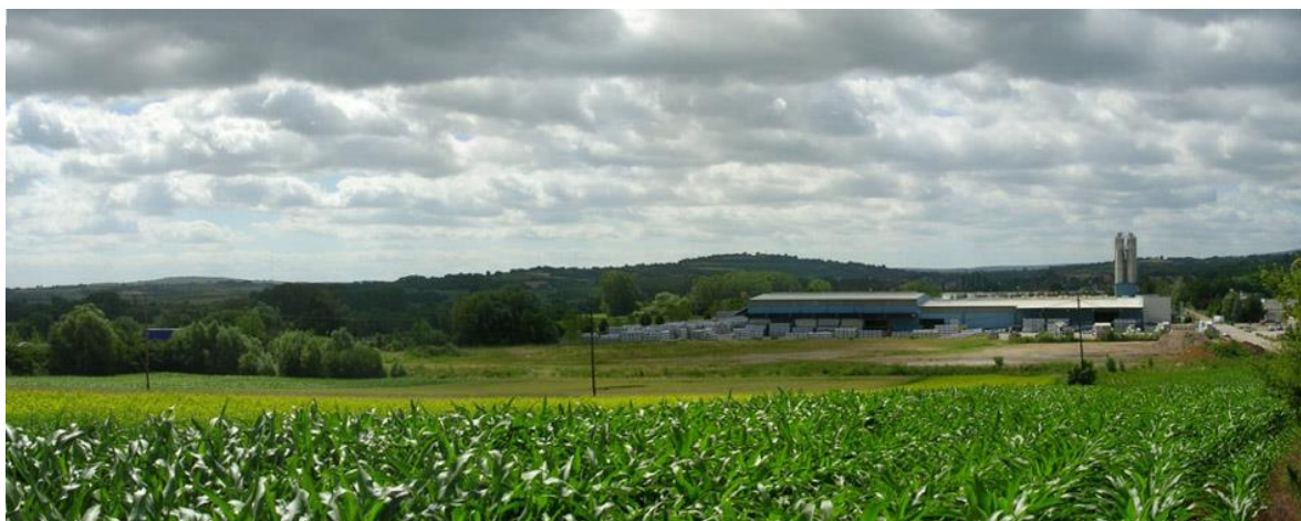
Vue sur la zone d'activités depuis la RD629 (avant l'aménagement de son extension)
