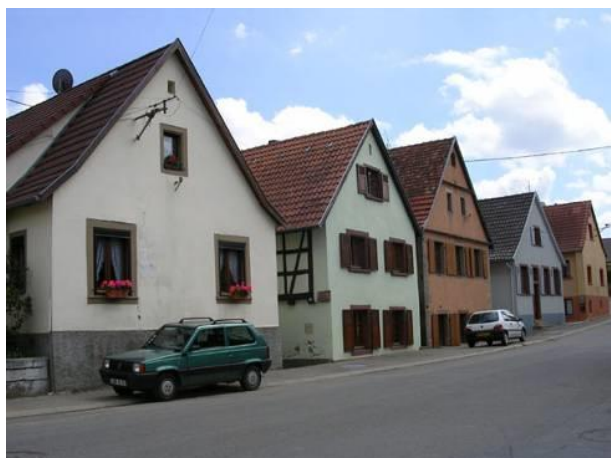
Rue du Général de Gaulle, un alignement d'habitations traditionnelles
