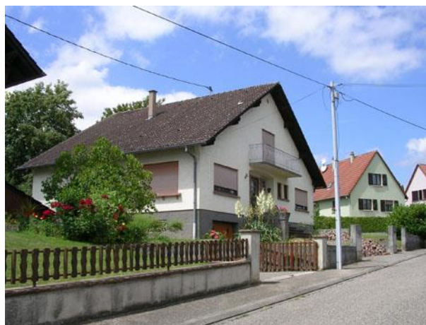
Maison de type chalet suisse, deux niveaux d'habitation (R+1), pignon sur rue et toiture débordante
