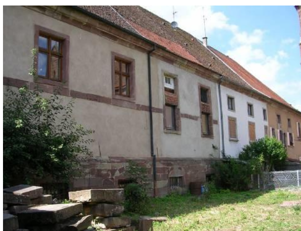
Bâti conventuel, rue du couvent : soubassement et encadrement de fenêtres en pierre de taille en grès
