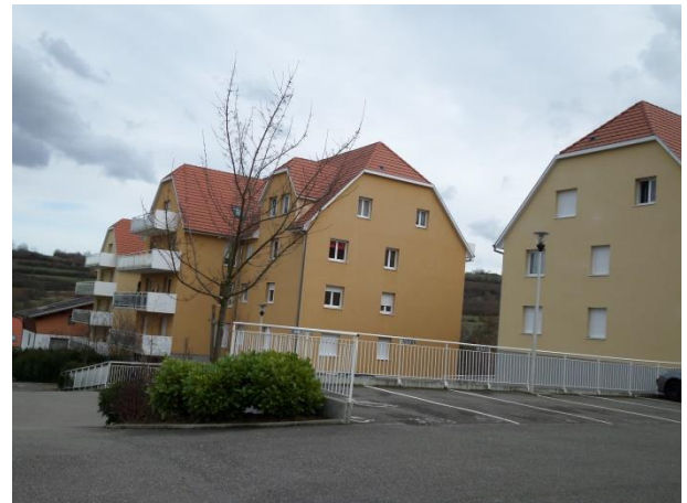
Logements collectifs rue du Général Leclerc
