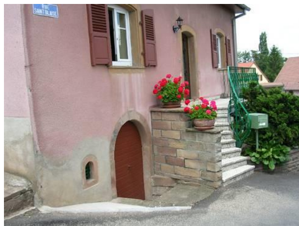
Remaniement en façade peu en rapport avec l'architecture traditionnelle, ajout d'un muret et d'un escalier carrelé
