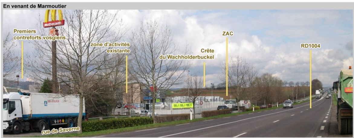
Vue à partir des abords de la RD1004, en face du centre commercial "Leclerc"
