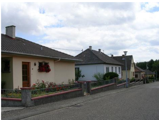
Maison du type bassin parisien, un seul niveau avec toiture à quatre pans
