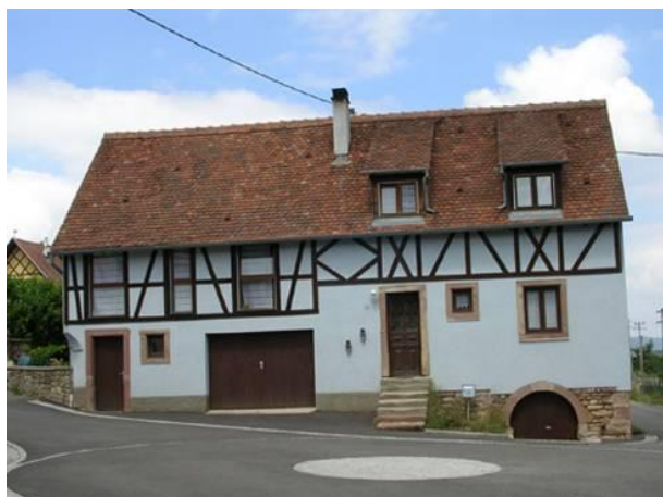
Architecture typique du Sindelsberg, grès et colombages, cave à demi enterrée
