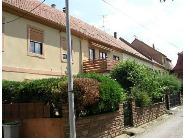
Rajout de terrasses et de clôtures opaques, peu en rapport avec l'architecture originale ; perte des volets en bois au profit de volets roulants
