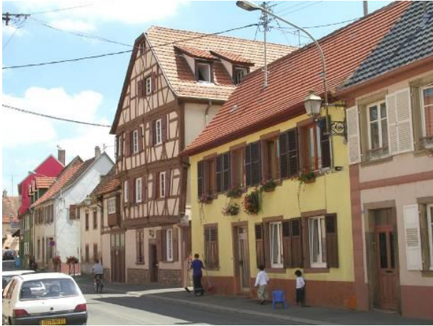
Rue du Maréchal de Lattre de Tassigny, coexistence des deux premiers types d'architectures décrits
