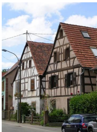
Deux maisons d'architecture traditionnelle : les colombages sont apparents
