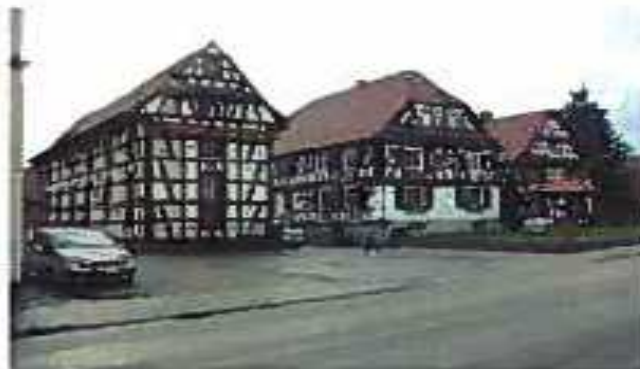
Photo 4 : Grange-séchoir à tabac à Surbourg
