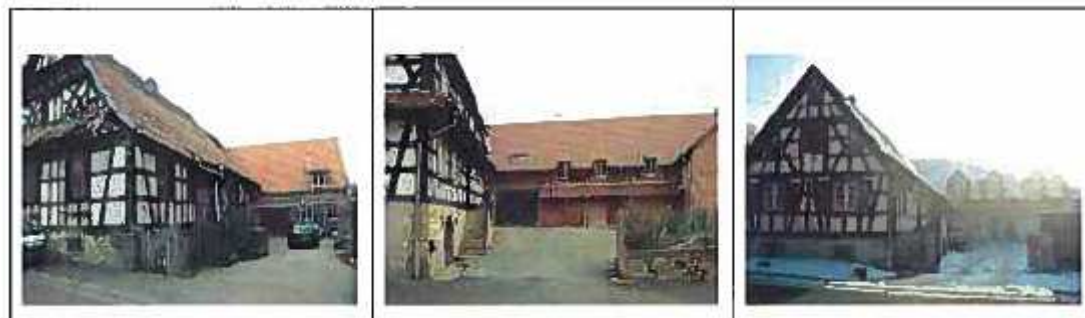
13 a, b et c : Exemples de réhabilitation de granges en logements
