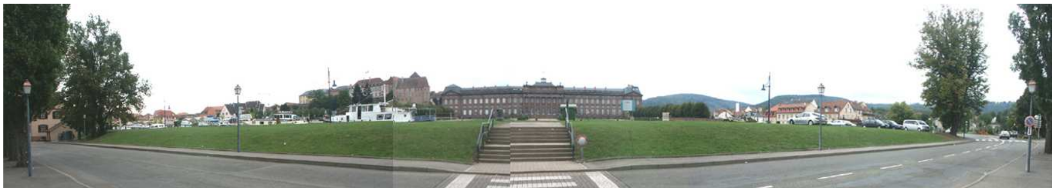
6. Vue panoramique sur le château et le canal de la Marne au Rhin depuis la rue de l'orangerie
