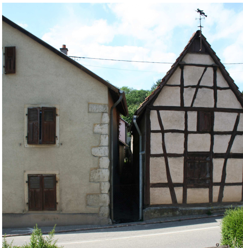
Deux constructions implantés pignon sur rue en limite de l'espace public
