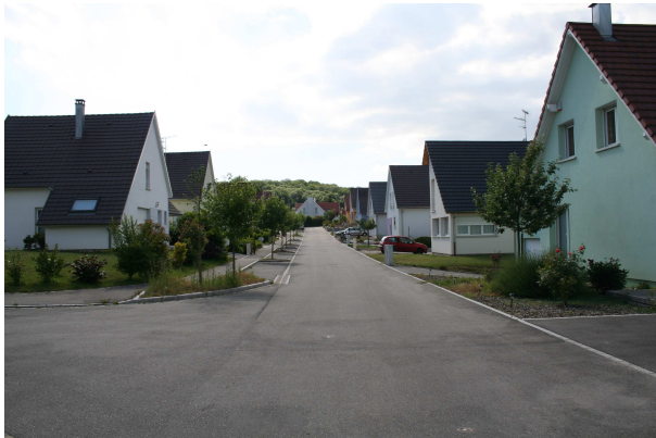
Traitement de voirie cohérent agencé autour d'une chaussée étroite, d'un alignement homogène à 5 mètres avec pignon sur rue, d'un cheminement piétonnier, et d'arbres autour des stationnements.
