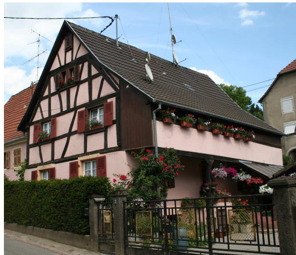
Construction à pans de bois datant de 1691 : la présence de la ligne électrique et de la parabole de couleur blanche banalise un peu le bâtiment
