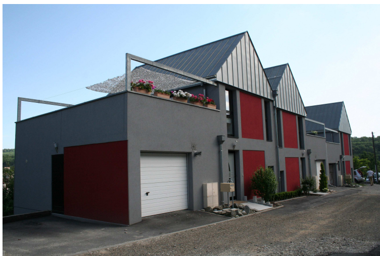
Constructions récentes à vocation d'habitat collectif en surplomb du centre du village
