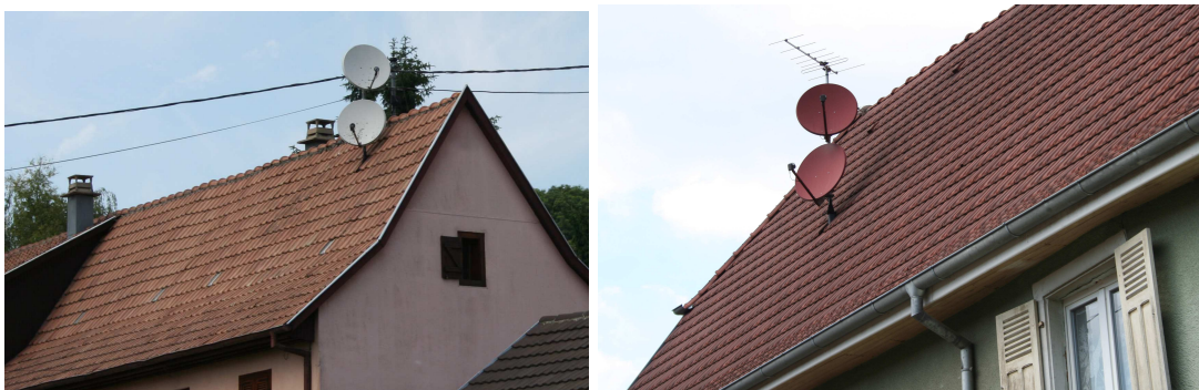
L'utilisation d'une parabole blanche dépassant le faîte du toit accroît son impact visuel
