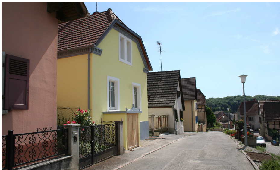
Façade urbaine de la rue du Corps de Garde
