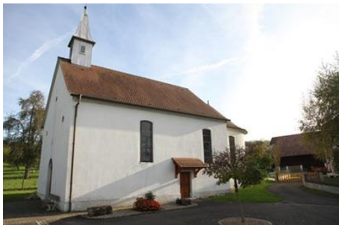
Chapelle de la Croix miraculeuse
