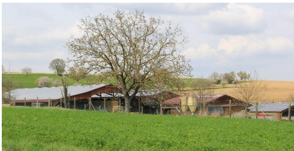
Exemples de bâtiment agricole isolé avec un fort impact visuel sur le paysage
