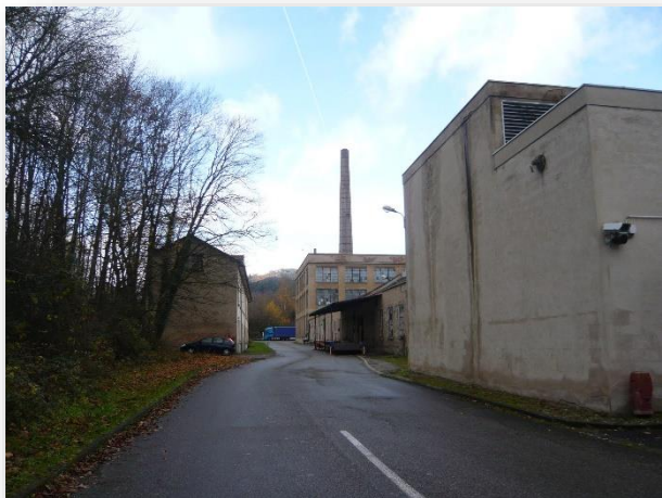
L'entrée du site par la rue des Remparts
