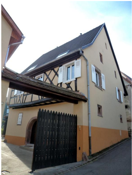
N°5 – XVIIIe – XIXe s., ancienne ferme de vigneron avec étage en colombages en encorbellement sur cour. Entrée charretière à linteau droit, entrée de cave voûtée, datée 1729.
