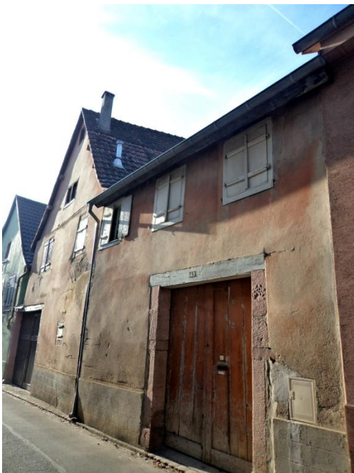
N° 5 – XIXe s., peut-être sur bases plus anciennes – Petite ferme de vigneron, maçonnerie et colombages sous enduits. Passage charretier surbâti avec porche à linteau droit. Entrée de cour du N°3 (au fond) empiétant sur le rez-de-chaussée de la maison.
