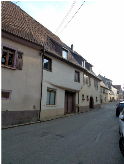
N° 12 – XVIIe s. – Petite ferme-cour de vigneron, maçonnerie et étage d'habitat en encorbellement en colombages enduits. Passage charretier surbâti avec porche. L'encorbellement est disposé de façon à ménager une fenêtre d'angle dans l'enfilade de la rue.
