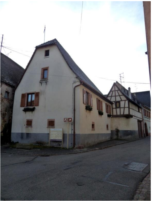
N° 24 – XVIe – XVIIe siècles, peut-être sur bases plus anciennes, ancienne ferme-cour de vigneron élevée sur cave en rez-de-chaussée. Position marquante au carrefour de la rue du moulin. Passage charretier surbâti d'une extension en colombages.
