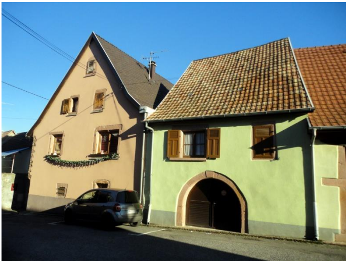
N°6 (XVIIe s., à gauche) et partie nord des dépendances du N°4 (à droite). L'habitation du N°6 comporte des fenêtres à appuis saillants, celle de droite avait à l'origine un meneau. L'annexe du N°4 est une porte de cave datée 1703, surbâtie d'une annexe formant habitation.
