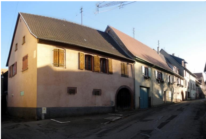
N° 10, 8, 6 et 4 – XVIIIe – XIXe siècles sur bases pouvant être plus anciennes. Bel alignement de fermes-cours mitoyennes à entrées de caves sur rue formant porches surbâti.
