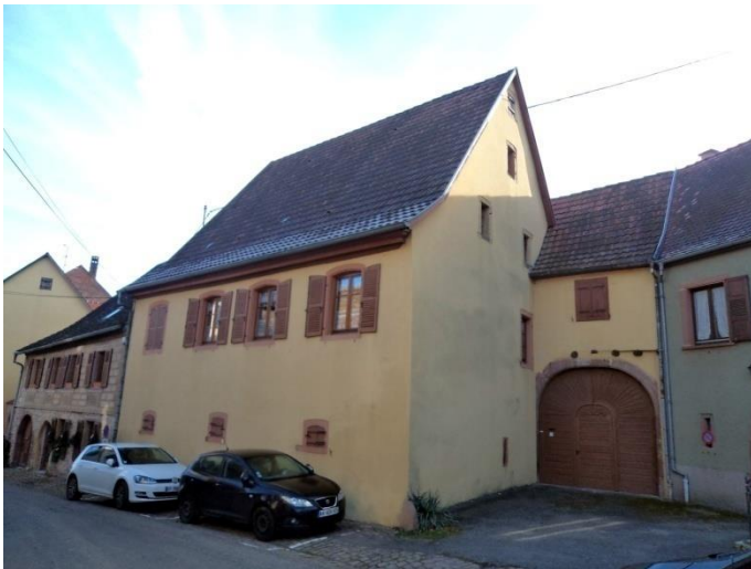
N°3 –XVIII e siècle, maçonnerie enduite. Passage charretier indépendant surbâti avec porche.
