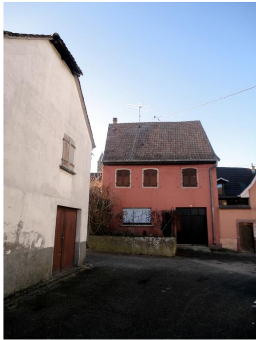
N°17 –XVIIIe - XIXe s., peut-être sur bases plus anciennes. Maison de vigneron en maçonnerie, encadrements à linteaux cintrés. Rez-de-chaussée avec porte de cave, transformé à usage d'habitation. A g., pignon nord du N°11.
