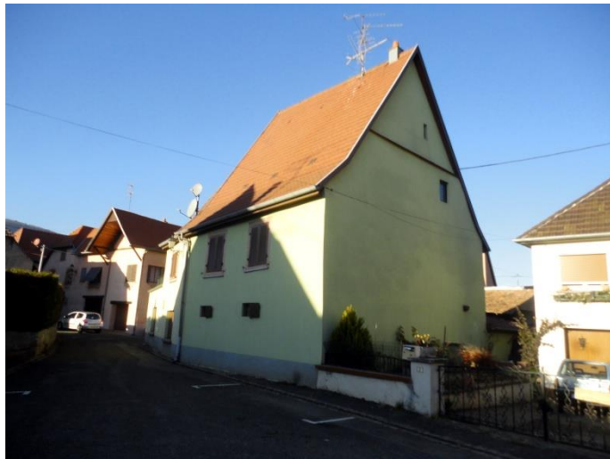
N°4 –XVIIIe - XIXe s., peut-être sur bases plus anciennes. Habitation de vigneron en maçonnerie élevée sur cave. Pignon aveugle résultant probablement de la démolition d'un mitoyen. Ensemble très remanié
