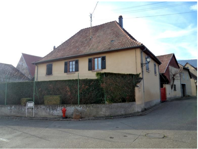
N° 20 –XVIIIe – XIX e siècles. Ferme-cour de vigneron à bâtiments dissociés, toiture à croupes, cave en rez-de-chaussée à entrée voûtée.
