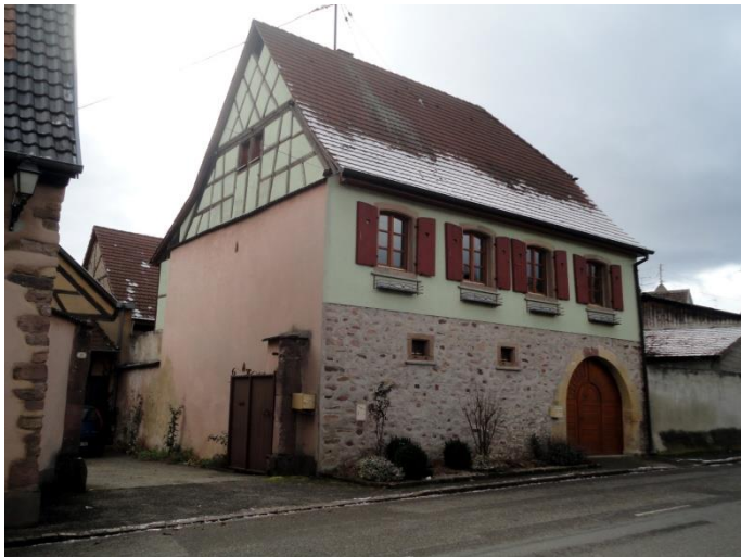
N° 28 – XVIIIe – XIXe siècles. Ferme-cour de vigneron, maçonnerie enduite. Passage charretier surbâti avec porche.
