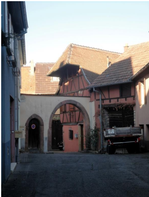
N°23 - 25 – XVIe - XVIIIe s. : anciennes fermes de vigneron en maçonnerie avec porches sur rue, celui du N°25 étant surbâti d'un grenier ou fenil à colombages. Dans la continuité, intéressant bâtiment annexe du N°27, rue du Fossé, à colombages en encorbellement et demi-croupe en surplomb.
