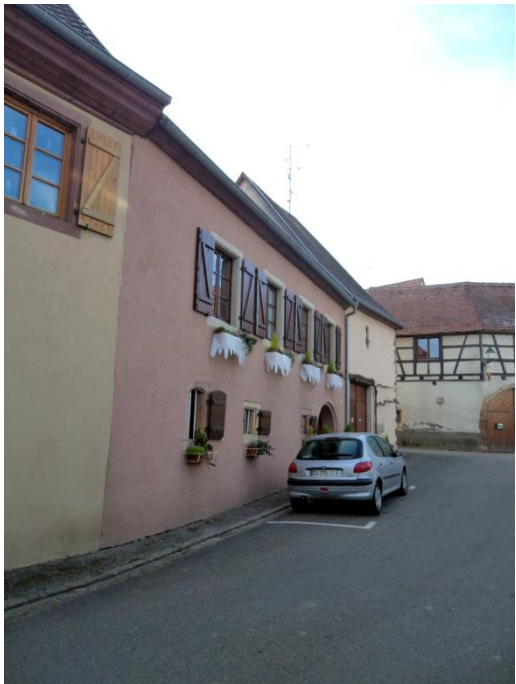
N° 12 – XVIIIe –XIXe siècles, peut-être sur bases plus anciennes. Ferme-cour de vigneron à passage charretier et porche voûté surbâti, extension latérale avec porte charretière formant grange.
