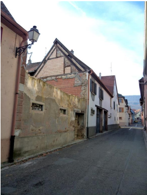
N°24 (démoli : XVIIIe - XIXe s.) - 22 (à droite, XVIIIe s.) : anciennes fermes de vigneron en maçonnerie avec porches sur rue à linteaux droits, dédoublés au N°22. La façade principale du N°22 donne sur la rue du Fossé.
