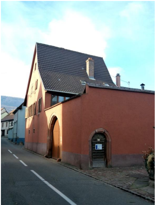
N°29 - XVIIIe s. : ancienne ferme de vigneron en maçonnerie avec porche de cour voûté (date 1721), porte piétonne également voûtée disposée en retour d'équerre (déplacée ?), corps d'habitation remanié.
