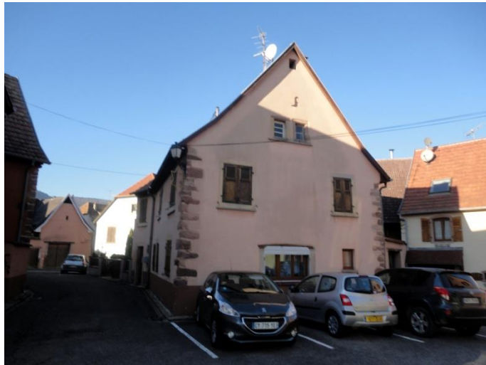
N°14 – XVIIIe - XIXe s., peut-être sur bases plus anciennes. Ferme de vigneron en maçonnerie. Rez-de-chaussée avec porte de cave en pignon, transformé à usage d'habitation
