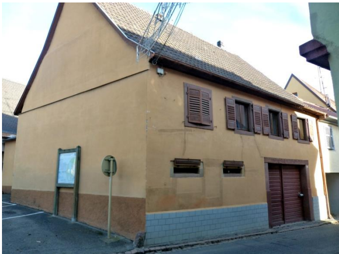
N° 34 –XIXe siècle. Ancienne ferme-cour de vigneron avec passage charretier à porche incorporé, à linteau droit. Etage vraisemblablement en colombages enduits.
