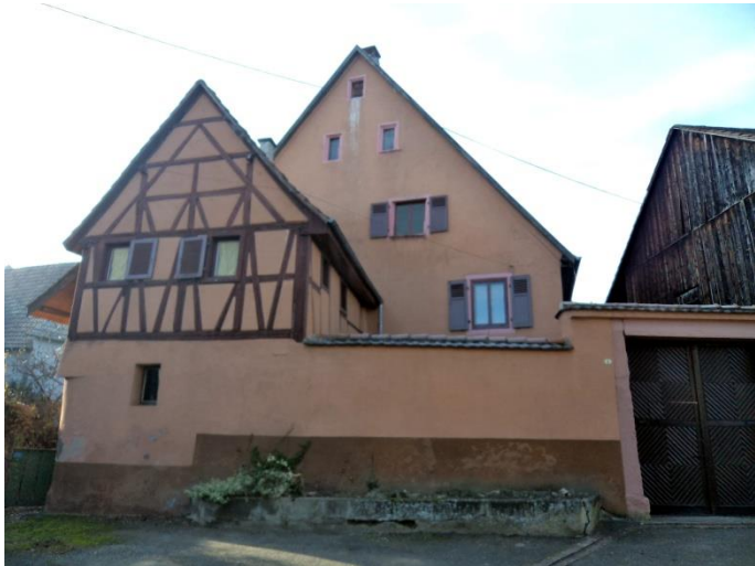
N°4 – XVIIe – XIXe s. Ferme-cour de vigneron, avec porche à linteau droit en mur de clôture. Intéressante extension en pignon de la maison, avec étage en colombages, probablement XVIIe s.
