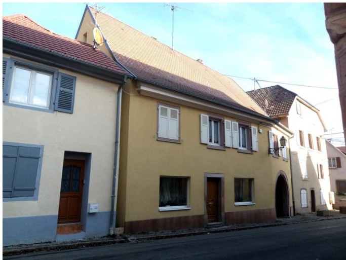
N° 32 - 30 – XVIIe –XIXe siècles. Petite maison à accès sur rue (N° 32) et ancienne ferme-cour de vigneron-tonnelier avec passage charretier à porche surbâti voûté (N°30). Ouvertures créées ou reprises au XXe siècle, peu heureuses (rez-de-chaussée N°30).
