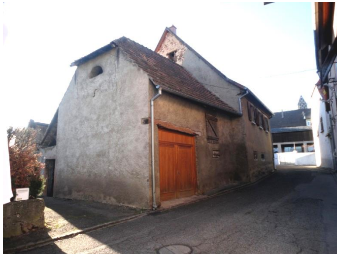
N°3 –XIXe s., peut-être sur bases plus anciennes. Habitation de vigneron en maçonnerie élevée sur cave, mitoyenne d'un seul côté. Porche de cour surbâti d'une annexe formant grange.
