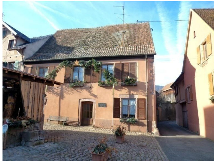
N° 9 – XVIIe -XVIIIe siècles, maçonnerie enduite. Cellier partiel en rez-de-chaussée. Couverture ancienne. Belle présentation.
