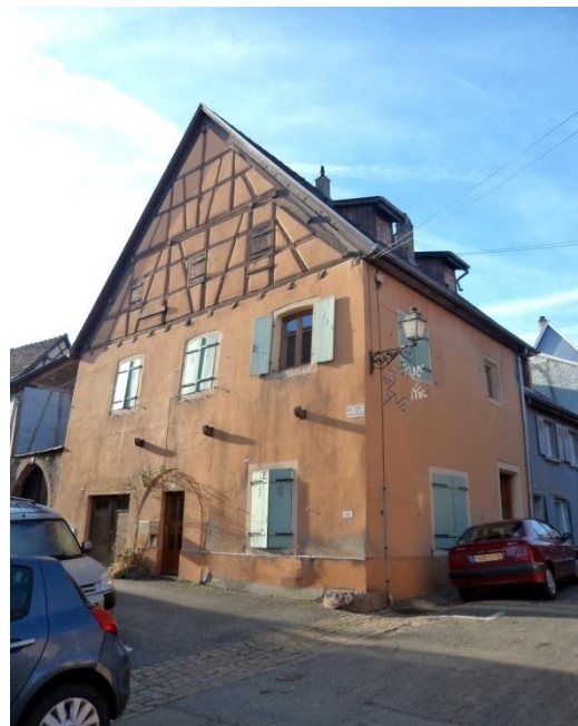
N°1 –XVII e – XIX e siècles, maison enclavée, maçonnerie enduite et pignon à colombages apparents sur rue. Porche de cave. Traces de balcon-galerie en pignon.
