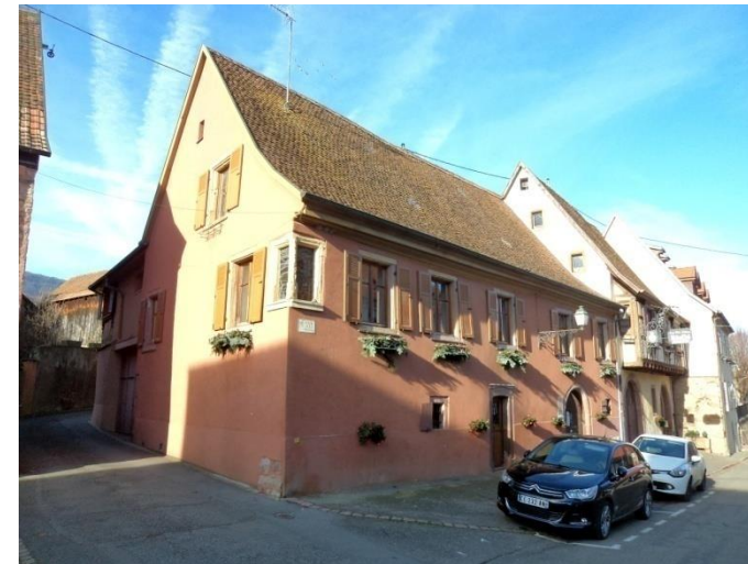
N° 11 – XVIIe -XVIIIe siècles, maçonnerie enduite. Cellier en rez-de-chaussée. Remarquable fenêtre d'angle en étage. Couverture ancienne. Belle présentation.
