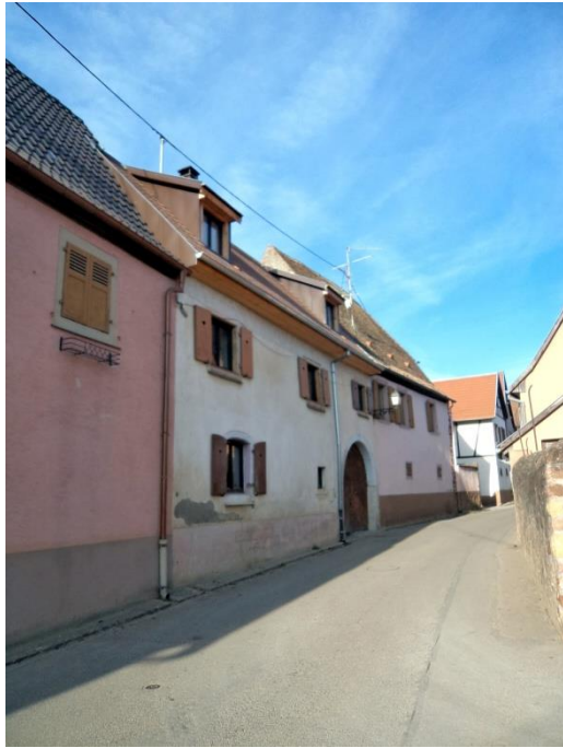
N° 6, 4 et 2 – XVIIIe – XIXe siècles sur bases pouvant être plus anciennes. Alignement de fermes-cours mitoyennes, les N°6 et 4 à entrée de cave sur rue formant porche surbâti.
