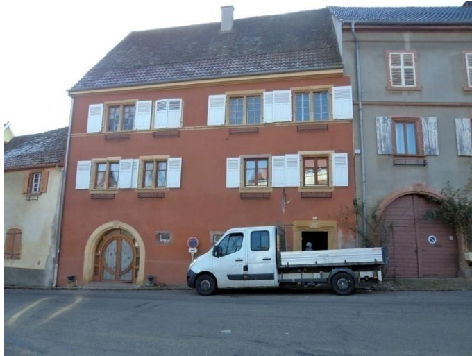
N° 3 – Fin XVIIe siècle Ancienne ferme-cour de vigneron. Maison à deux étages de belle qualité, détails soignés (moulures, balcon-galerie en encorbellement. Toitures tuiles mécaniques.
