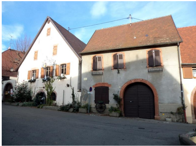
N° 13 – XVIIIe – XIXe siècles, peut-être sur bases plus anciennes. Ferme-cour de vigneron avec porche voûté surbâti sous habitation (daté 1777). Vue de la façade sur la place Notre-Dame, à g. le pignon du N°7 de cette place.
