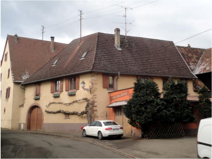
N° 27 – XVIIe – XVIIIe siècles, peut-être sur bases plus anciennes, ancienne ferme-cour de vigneron élevée sur cave en rez-de-chaussée. Résulte peut-être d'une division ancienne avec le N° 25. Passage charretier surbâti avec porche.
