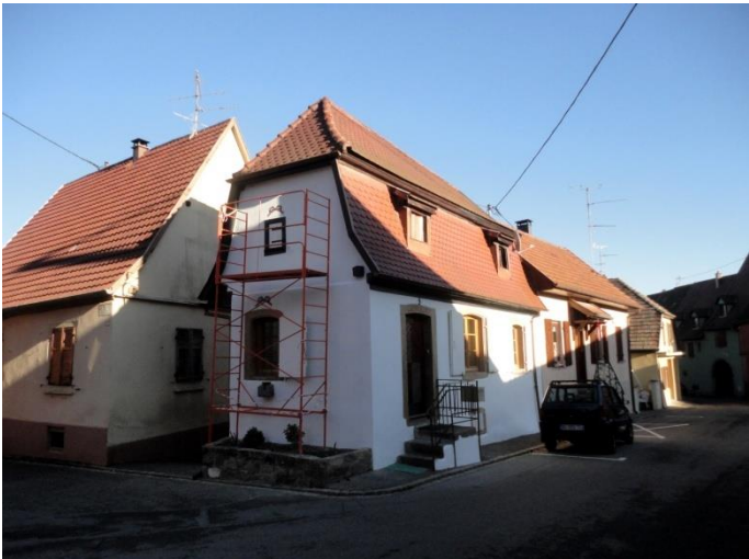
N°5 – début XIXe s. Petite maison de vigneron en maçonnerie et colombages enduits sous toiture à la Mansart. Emprise au sol très réduite.
