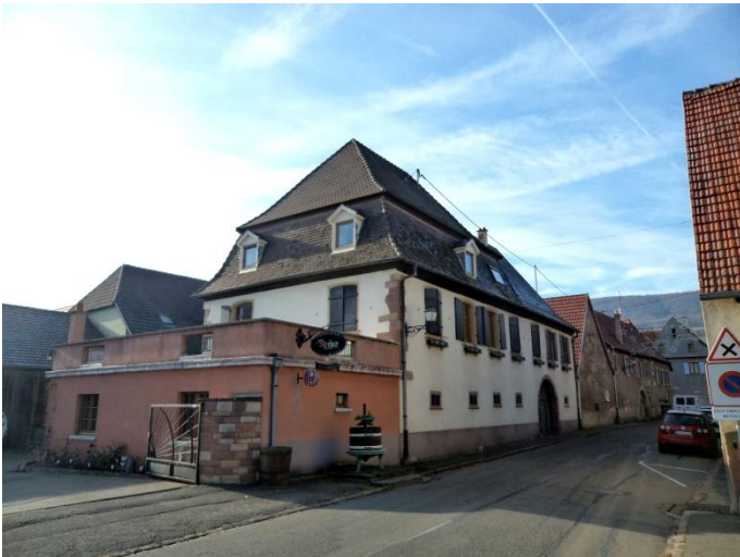
N° 21 – XVIIIe –XXe siècles. Grande ferme-cour avec toiture à la Mansart, passage charretier à porche voûté surbâti d'une extension ultérieure de l'habitation, sous toiture à deux pans. Extension moderne (est) à toiture terrasse peu heureuse.
