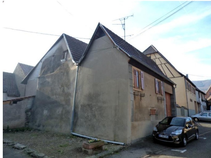
N°14 – XVIIIe – XIXe s. Petite maison de vigneron en maçonnerie et colombages enduits. Porche surbâti inscrit dans le volume, dépendance arrière accolée avec chéneau intermédiaire.
