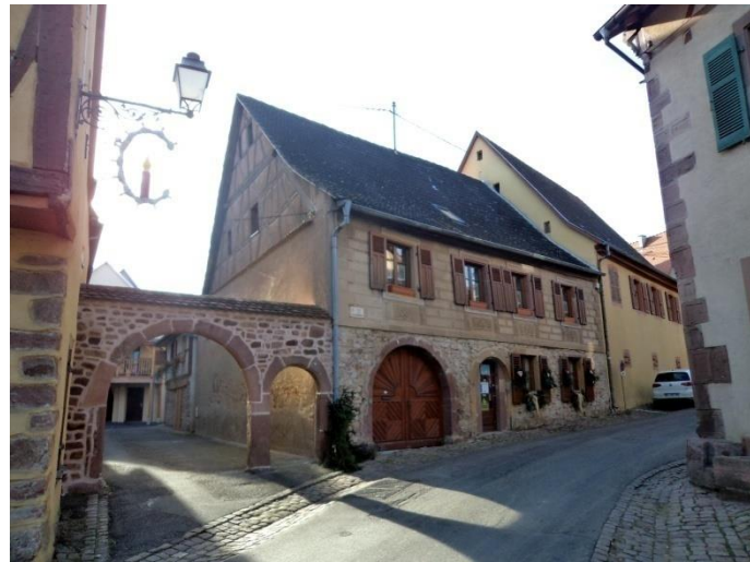
N°1 –XVIII e siècle, maçonnerie enduite et pignon à colombages apparents sur impasse. Passage charretier surbâti avec porche. Intéressant crépi décoratif (1907).
