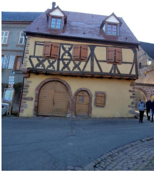
N° 5 –XVIIe siècle. Ancienne ferme-cour de vigneron à passage charretier surbâti et porche. Comble maison : reconstruction récente, tuiles plates, lucarnes raisonnables, mais suppression des brisures de coyaux
