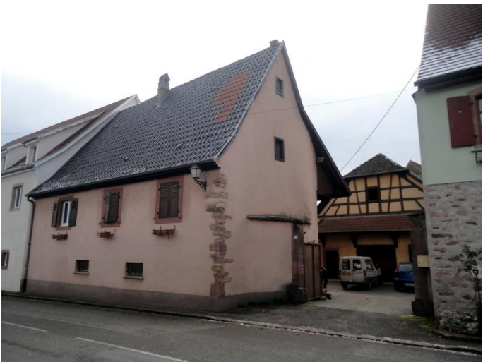
N° 30 – XVIIIe – XIXe siècles. Ferme-cour de vigneron, maçonnerie enduite.
