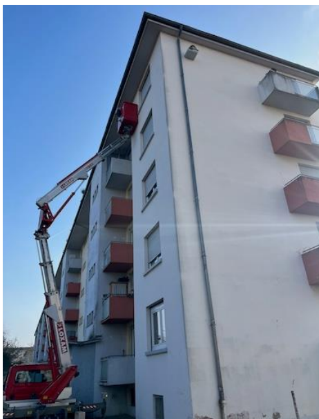
Figure 32 : Exemple de nichoir pour le Faucon crécerelle installé sur un bâtiment à Strasbourg, Meinau.
