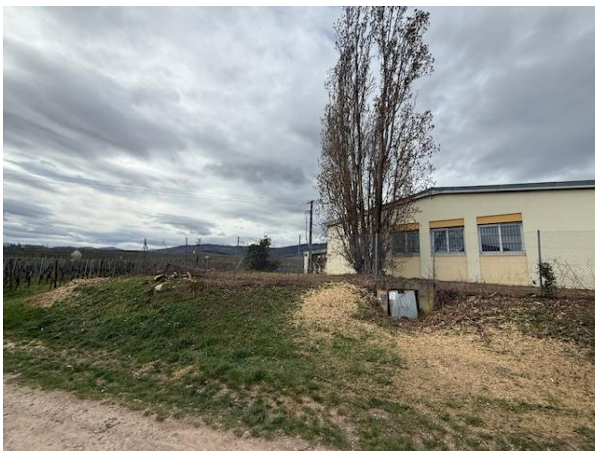
Figure 10 : Série photographique du site après les travaux de débroussaillage en mars
