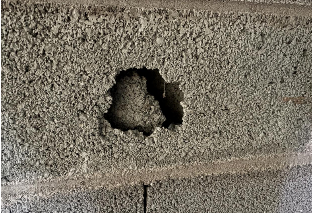
Figure 18 : Les rares cavités dans les moellons ont été explorées à l'endoscope
