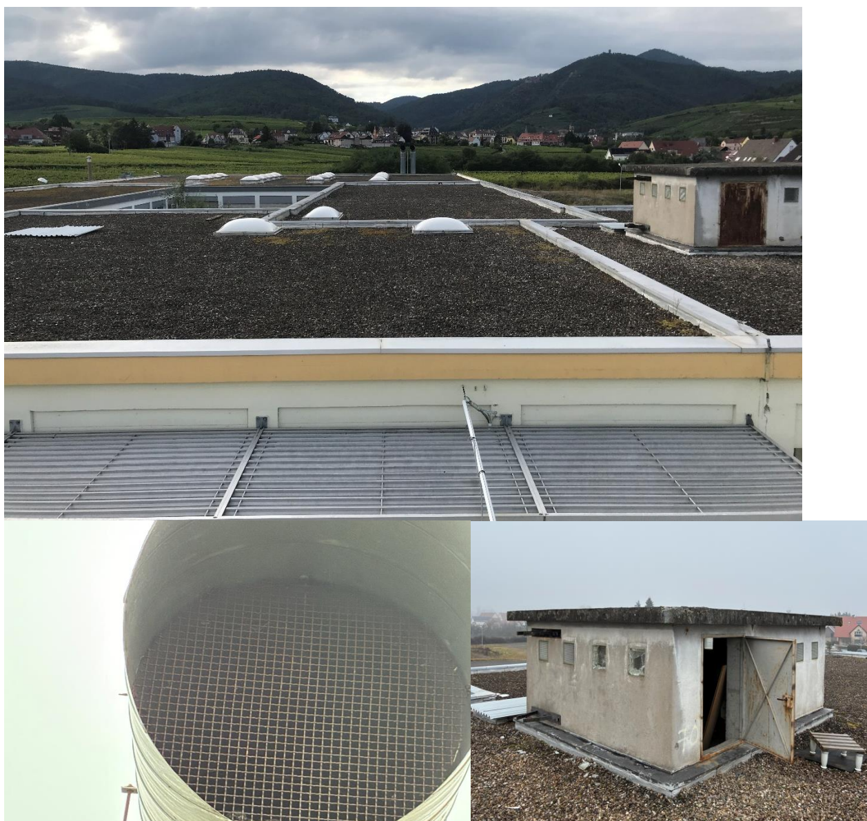
Figure 21 : Photographies de la toiture terrasse et des éléments présents
