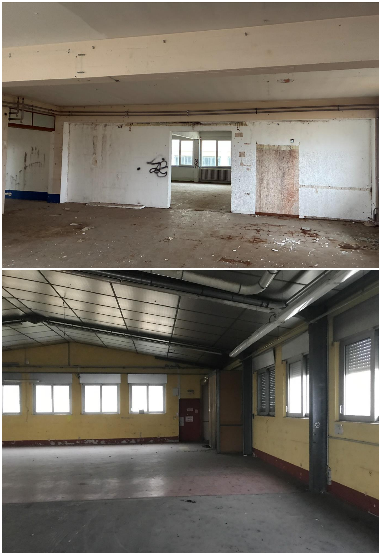
Figure 17 : Vue des cloisons intérieures
