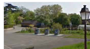
Bornes enfouies rue du Parc à Saint-Hippolyte
