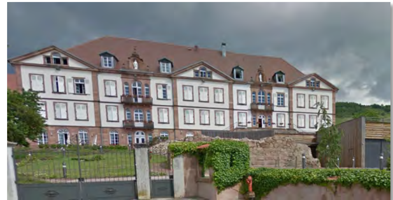
L'ancien château des ducs de Lorraine au nord-est du mur de fortification, dont on aperçoit un vestige au premier plan.
