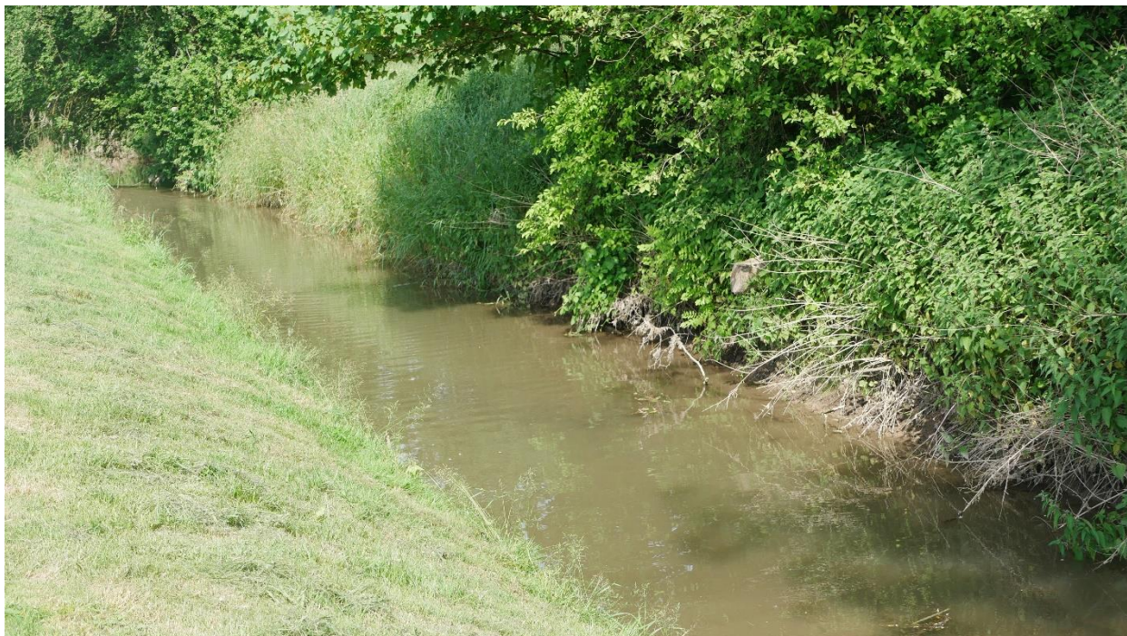
Lit mineur du Sauruntz à l'aval de la ville (CLIMAX, 2022)
