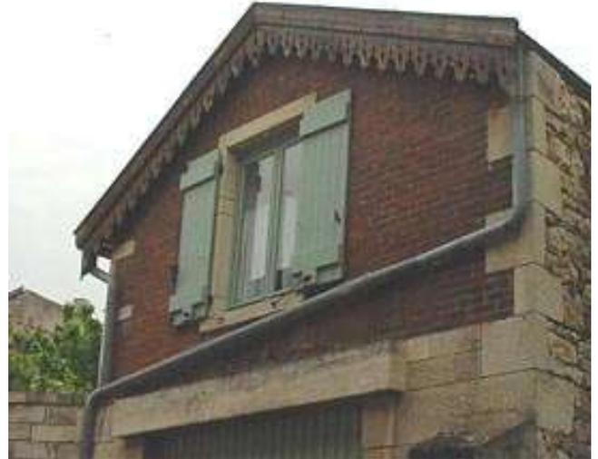
L'amélioration des techniques de moulage, à la fin du XIX<sup>e</sup> siècle, a permis de fabriquer des briques calibrées (22 x 11 x 5,5 centimètres, dites briques anglaises), aux arêtes vives, à la couleur uniforme, dites briques de parements.
