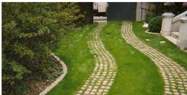
*Entrée de garage sol perméable (pavé joints enherbés)*
