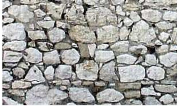
3- les façades sont en moellons de tout venant dont le format est plus important, avec un plus grand souci d'appareillage : on s'orientera vers l'enduit "à pierres vues" ou l'enduit "usé".
