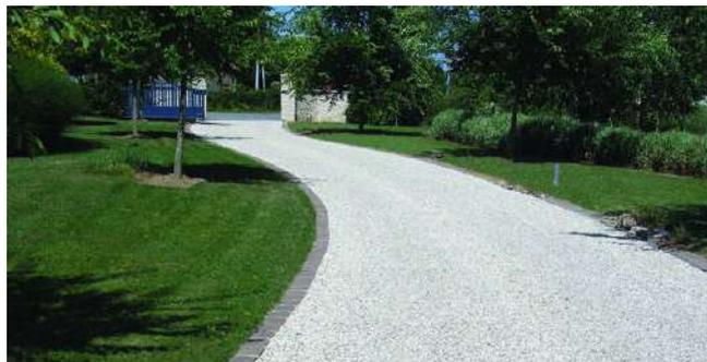
*Entrée de garage sol perméable (gravier renforcé)*
