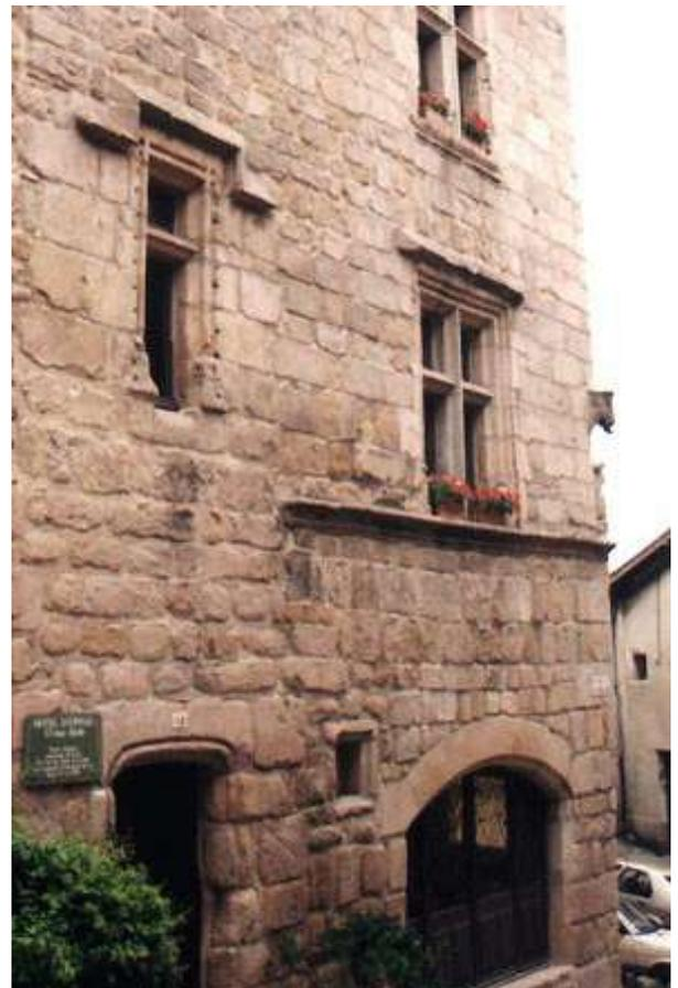
2- les façades en moellons de tout-venant, le format des pierres est plutôt petit, sans lit ni appareillage : l'enduit s'imposera.
