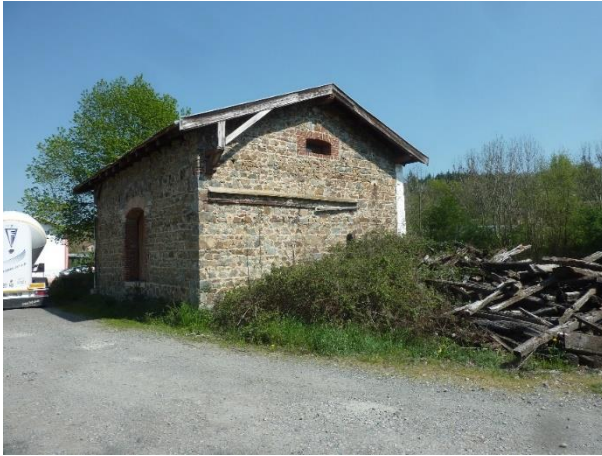
Bâtiment en pierre à démolir
