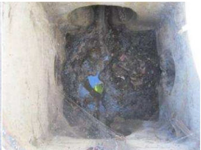
Dépôts (Regard n°41, en face caserne pompier)
