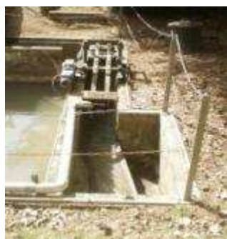
Dégrilleur automatique
