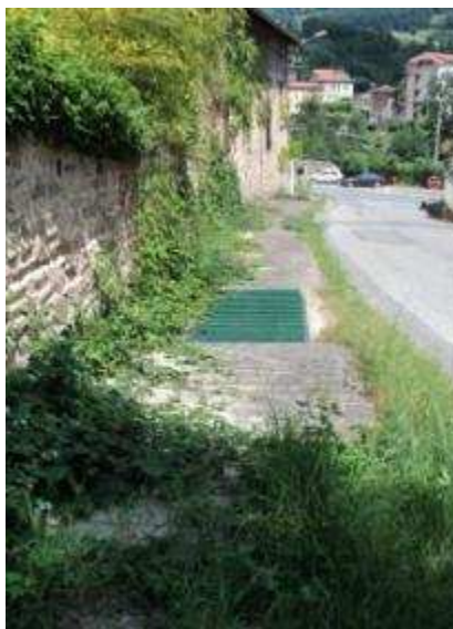
Canalisation du talweg (en amont du regard n°60)
