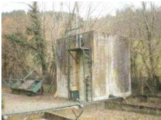
Silo à boues
