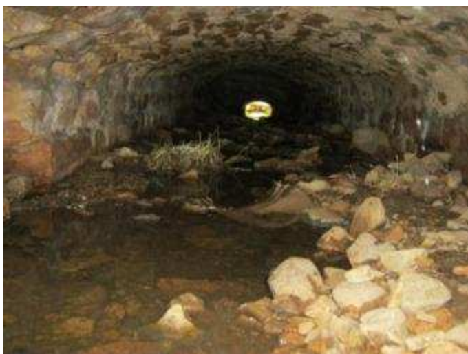
Passage du cours d’eau sous des bâtiments (prise au niveau du regard n°122)
