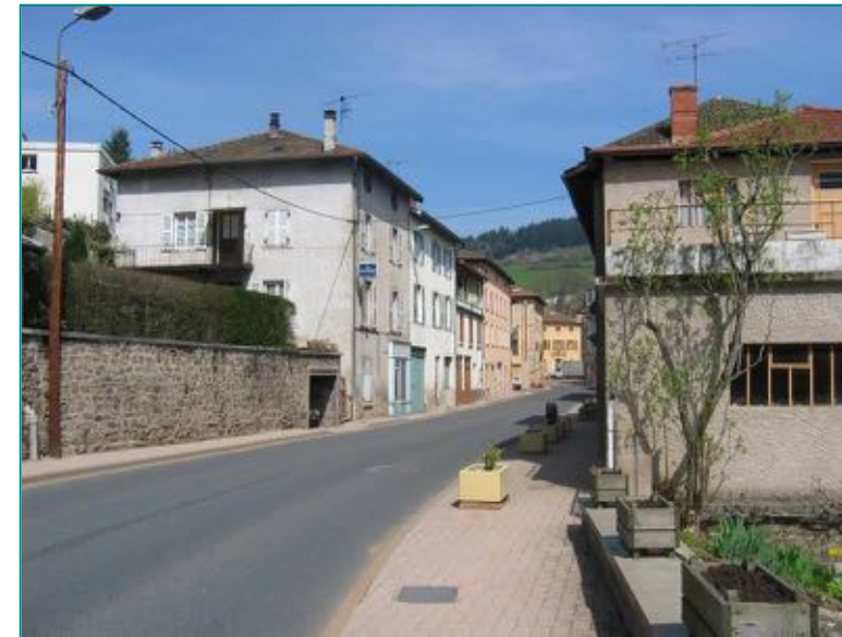
La RD 385 dans la traversée du bourg
