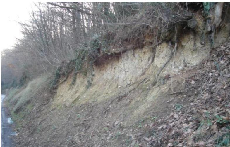
Figure 13 : arrachement dans le talus amont de la RD 5
