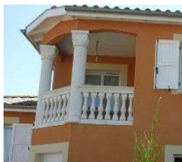
Type de balustres interdits
