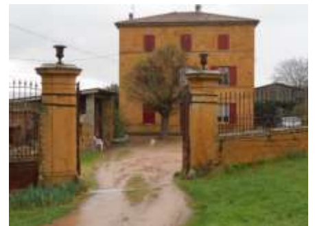
N°21 (portail et façade)
