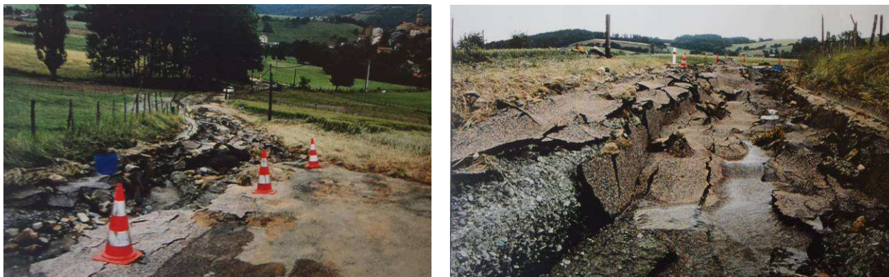
PHOTO 3 : DÉGÂTS AUX VOIRIES (RD 632 DANS LE SECTEUR DES RAMÉES)
