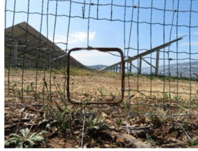
La mise en place de cadres en fer au niveau de ces trouées est importante pour renforcer le dispositif sur un temps long
