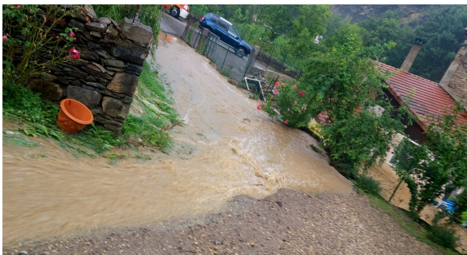
Figure III.6: Ruissellement de versant et débordement sur la voirie (2020). Le terrain et des habitations ont été inondés (à droite de l'image).
