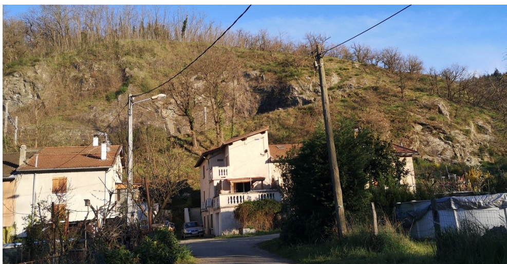
Figure III.9: Habitations en aval d'affleurements rocheux au lieu-dit le Moulin Glattard.
