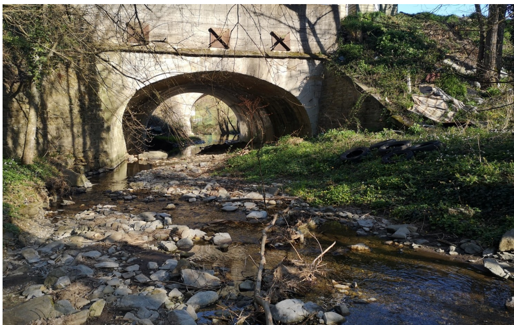
Figure III.3: Ouvrage routier traversant le ruisseau du Grand Malval
