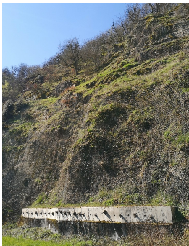
Figure III.8: Affleurement rocheux au niveau de tête nord-est du tunnel de France.
