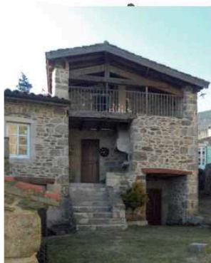
Exemple de débord de toiture
