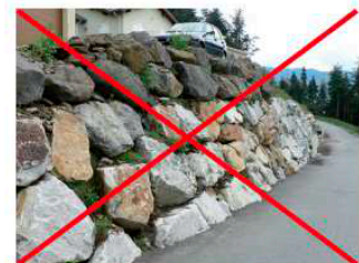
Enrochements de type cyclopéen
