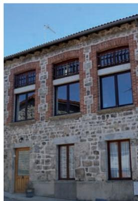
Exemple de traitement d'ouvertures permettant de conserver la verticalité du percement
