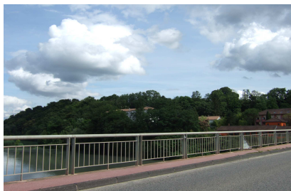
2. Vue sur la rive gauche
