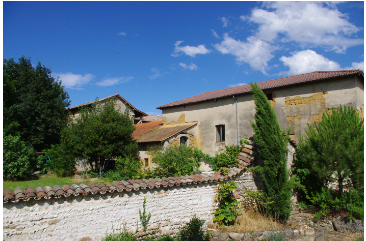
Illustration 13: Ferme du Confort présentant de nombreux sites accueillants pour la faune sauvage (grange, muret en pierre, pisé...)
