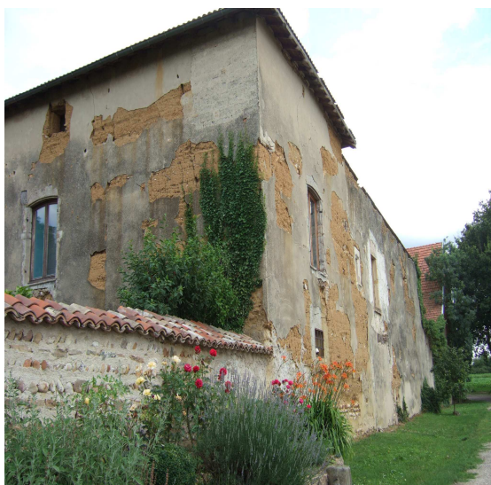
Ancienne maison forte, à Confort
