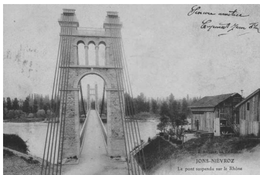
Ancien pont de Jons, en pierre de taille, remarquable avec ses pylônes formant arc monumental
