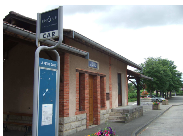
Ancienne gare (Route de Lyon)
