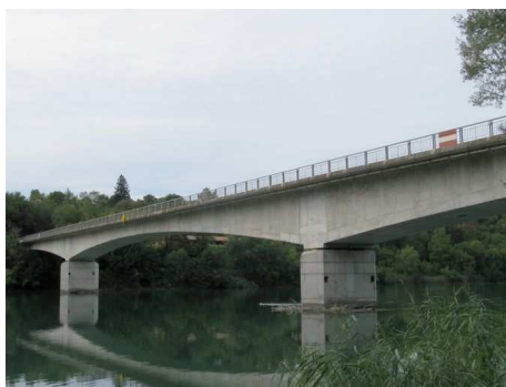
Nouveau pont de Jons, en béton précontraint
