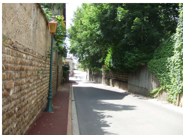
Mur soubassement galets (Chemin de Chantenoy)
