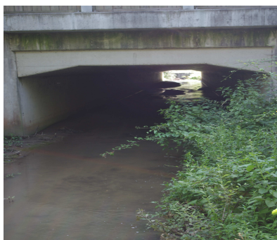
illustration 15: Ouvrage hydraulique de la Chana, sous l'A432
