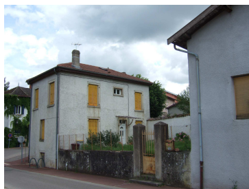
Bâti à restaurer Lieu-dit Bianne (3)
