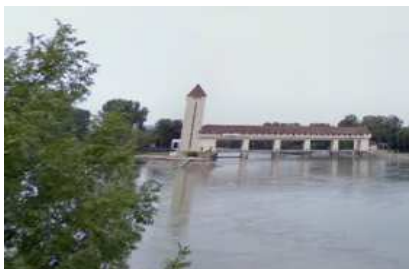
1. Barrage de Jons
