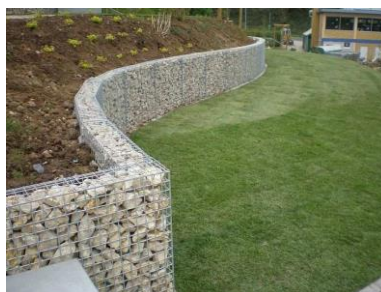
Muret en gabion
