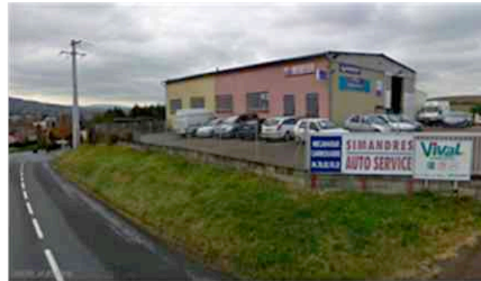
1- Bâtiment d'activités sur la rue de Fonderie
