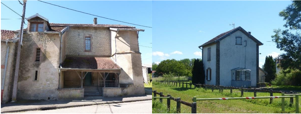
Une construction ancienne en retrait de la rue principale, avec une tour hexagonale et un parvis ancien, et une maison de garde barrière bien préservée.
